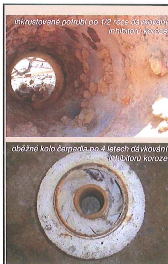
Obr.7 - Pohled do potrubí před a po dávkování inhibitorů koroze 3
