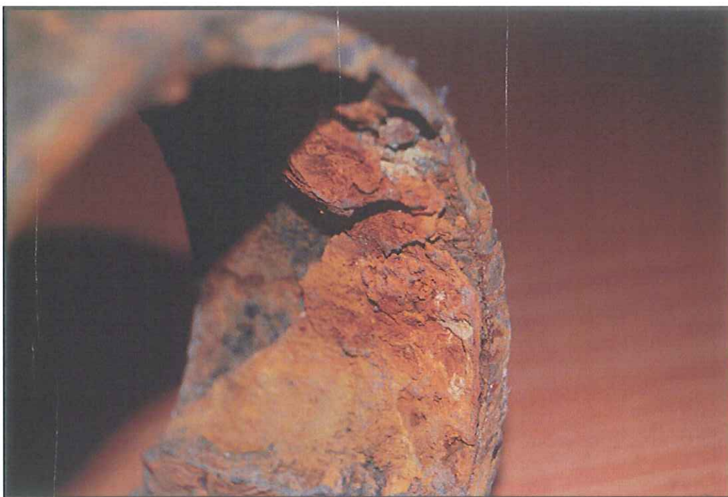
Obr. 17 - Výřez potrubí v obci Sovolusky
