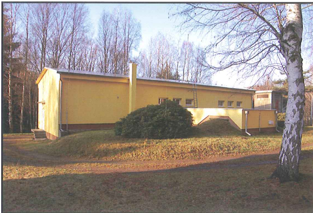
Obr. 4 - Úpravna vody Ostrov
