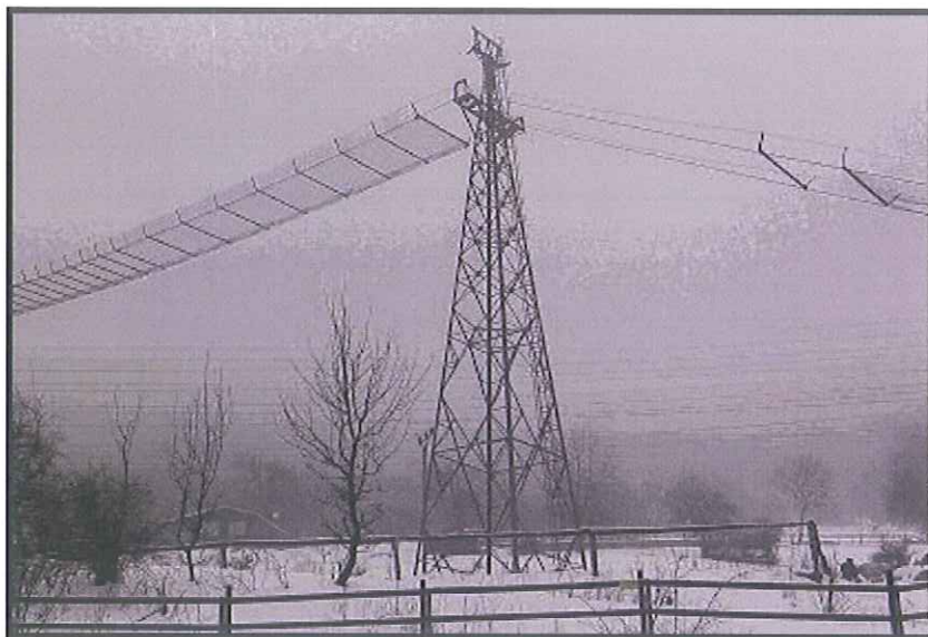
Obr. 2 - Část lanové dráhy
