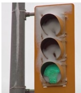
Obr. 1.6: Příklad zasněženého LED SSZ [4]
