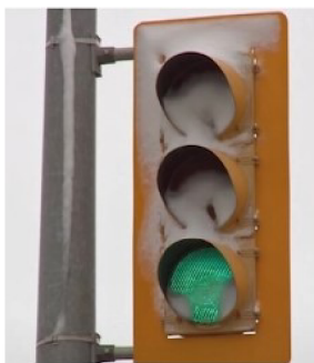
Obr. 1.6: Příklad zasněženého LED SSZ [4]
