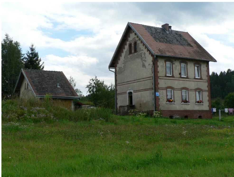
Obr. 22 Bývalá výpravčí budova Slone (29. 7. 2017, autor L. Volčík)
