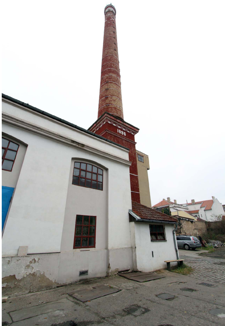
Zdroj: Litoměřice, Rekonstrukce části litoměřického pivovaru skončila , 2022
