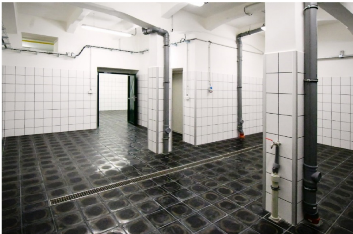
Zdroj: Litoměřice, Rekonstrukce části litoměřického pivovaru skončila, 2022
