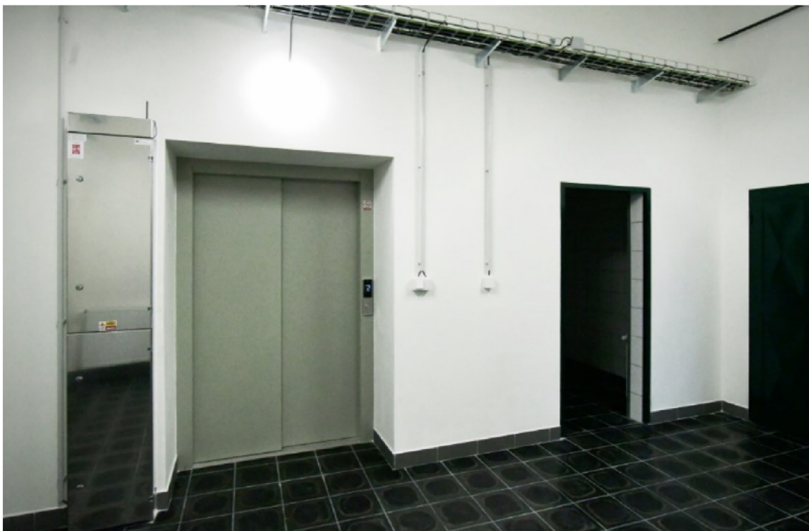
Zdroj: Litoměřice, Rekonstrukce části litoměřického pivovaru skončila, 2022
