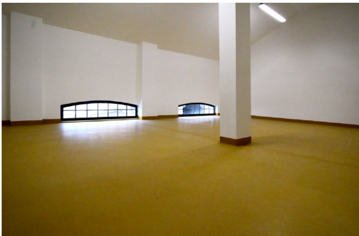
Zdroj: Litoměřice, Rekonstrukce části litoměřického pivovaru skončila , 2022
