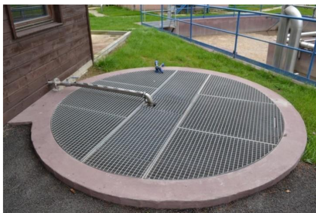
Obr. 6.5 - Lapák písku s potrubím obsahující načerpanou hydrosměs (sedimentovaný písek s vodou)
