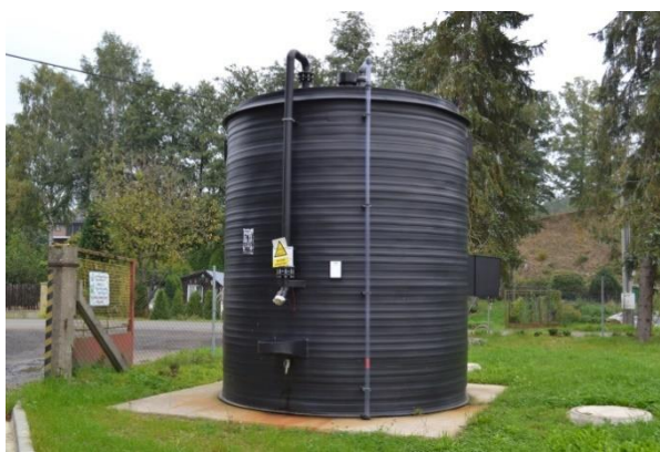
Obr. 6.12 - Nádrž s koagulantem \text{Fe}_2(\text{SO}_4)_3
