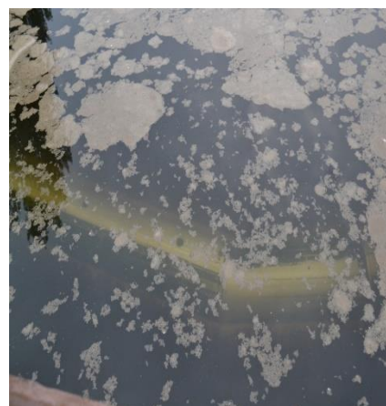
Obr. 6.10 - Pohled na hladinu dosazovací nádrže
