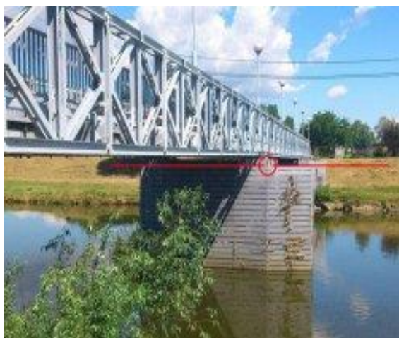
Obrázek 3 Hladinoměr – pěší lávka v Uherském Hradišti
