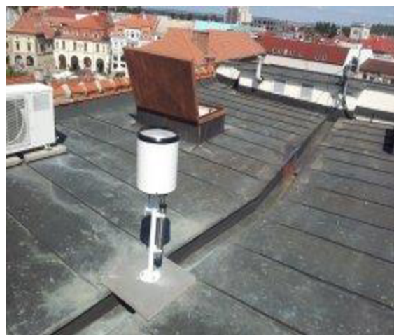
Obrázek 3 Srážkoměr – střecha městského úřadu v Uherském Hradišti
