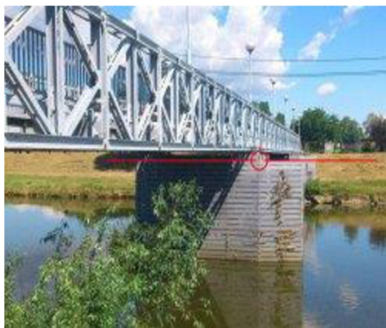
Obrázek 3 Hladinoměr – pěší lávka v Uherském Hradišti
