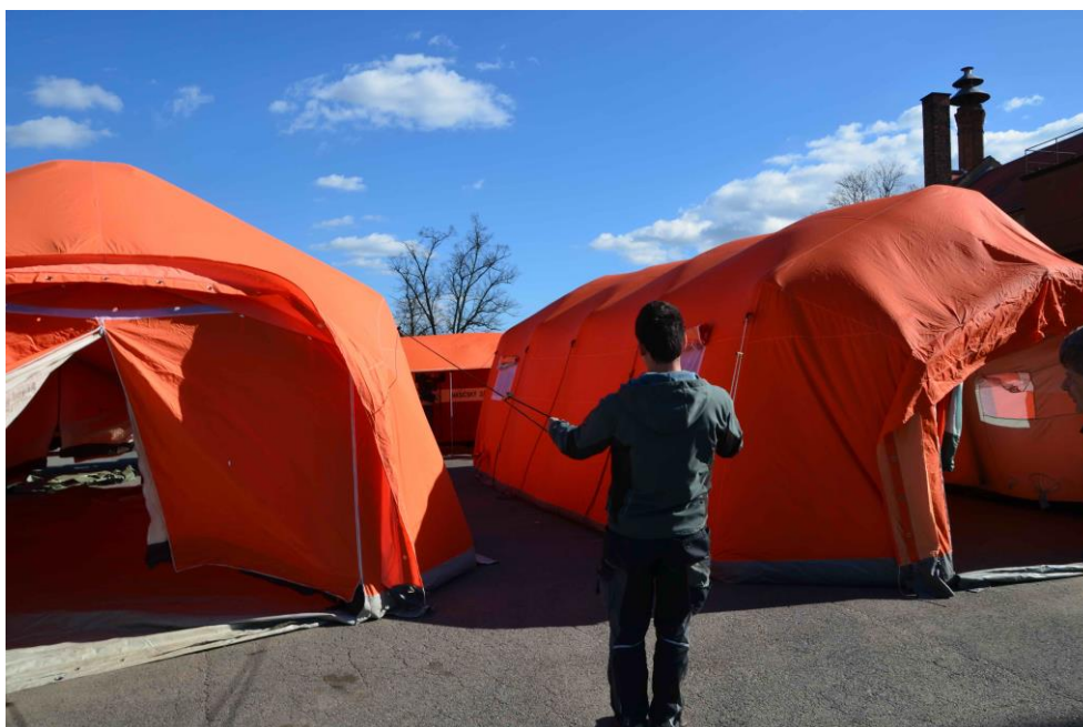
Obrázek P4 Napínání nafouklých stanů, zdroj: HZS Kraje Vysočina
