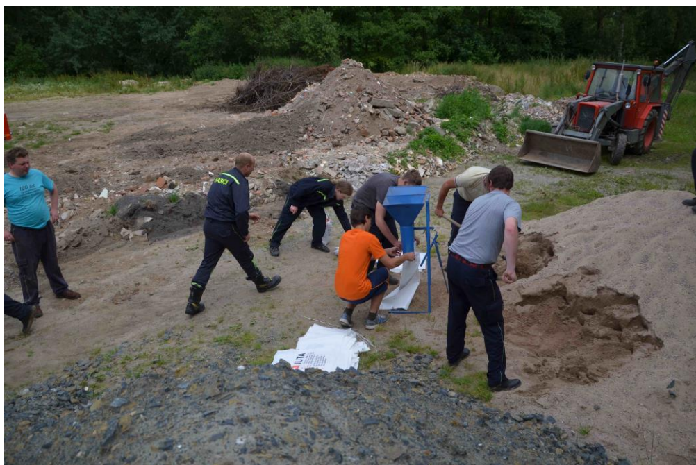
Obrázek P10 Plnění dvoukomorových pytlů pískem, zdroj: HZS Kraje Vysočina
