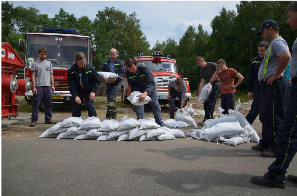
Obrázek P11 Stavba protipovodňové hráze, zdroj: HZS Kraje Vysočina
