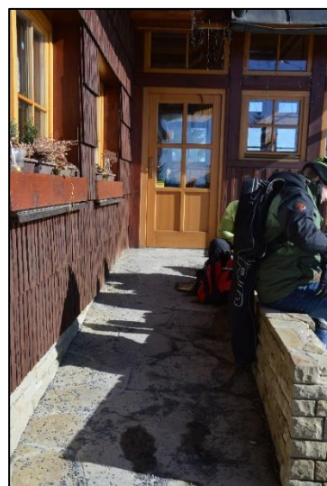
Obrázek 21. Vedlejší vstup do budovy.
