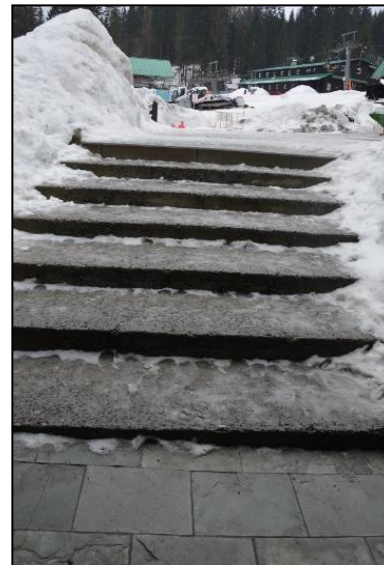
Obrázek 5. Vchod do hlavní budovy.
