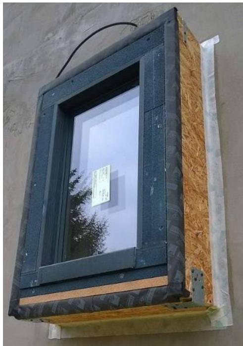
Obr. 2 Okno v OSB kastlíku [8]
