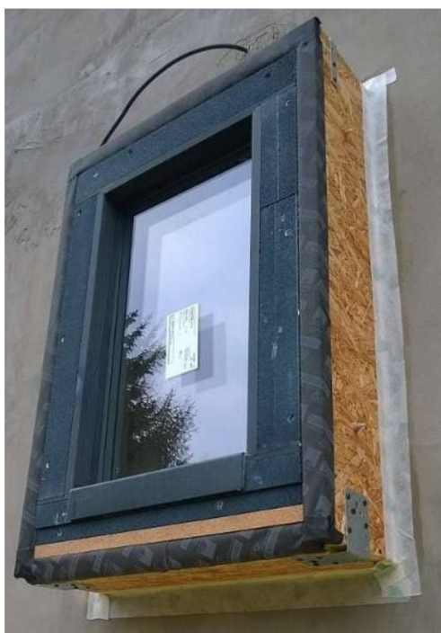
Obr. 2 Okno v OSB kastlíku [8]
