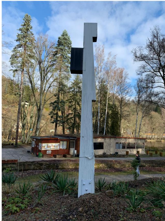
MATERIÁL: dřevo (dub), INFORMACE: oloupaná barva převážně ve spodní části , strana otočena směrem od kiosku ve vzhledově dobrém stavu FOTO: Lucie Juračková 2020
