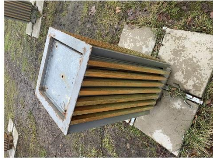
materiál: dřevo, kov informace: katalogového typu, známky koroze foto: Lucie Juračková 2020
