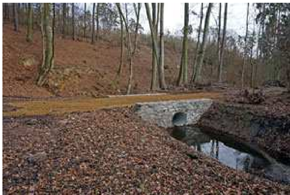
Obr. č. 12 Oprava a modernizace lesní cesty Pod hradiskem
