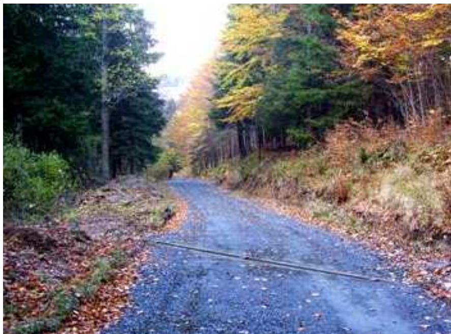
Obr. č. 11 Rekonstrukce lesní cesty Dolní Miroslav
