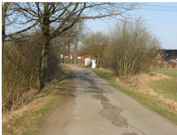
Foto č. 2: Pohled na obec z hlavní polní cesty Pv2
