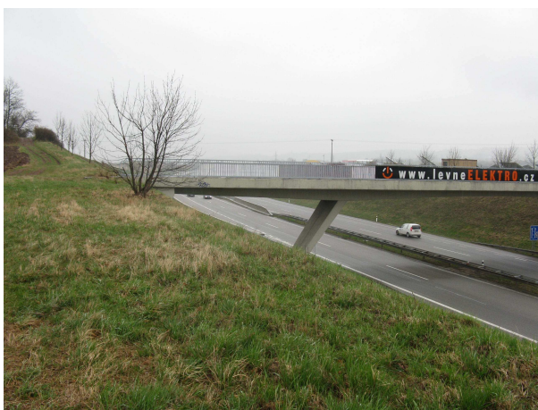
Foto č. 5: Mimoúrovňové křížení hlavní polní cesty P4 se silnicí I. třídy S I/34
