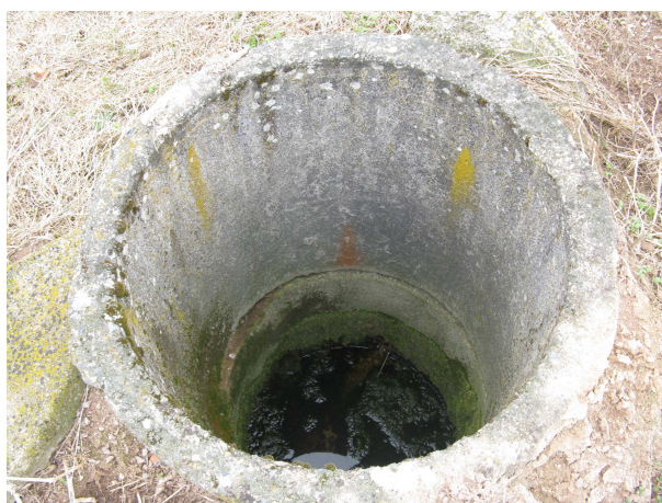
Foto č. 9: Kontrolní šachtice drenážního systému
