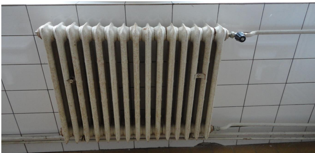
Obr.12 Súčasný stav vykurovacej sústavy
