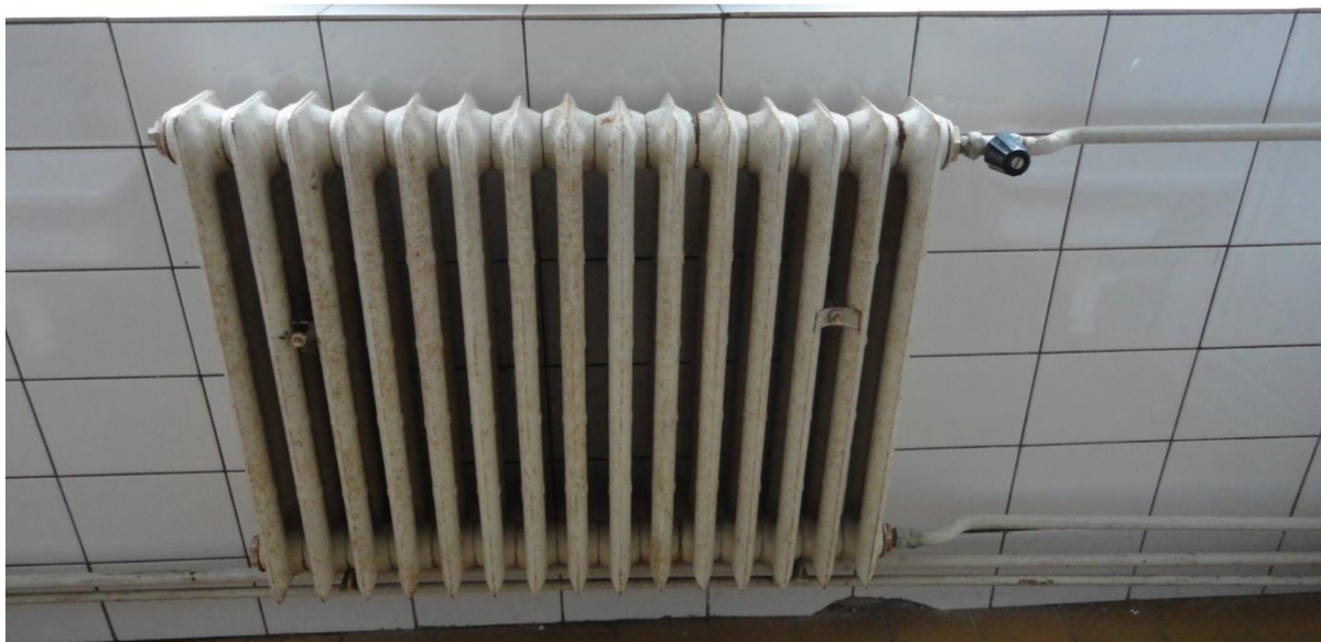
Obr.12 Súčasný stav vykurovacej sústavy
