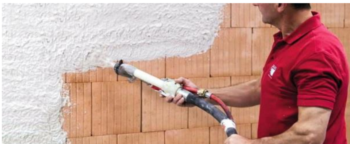
Obrázek 5: Aplikace tepelněizolační omítky [19]
