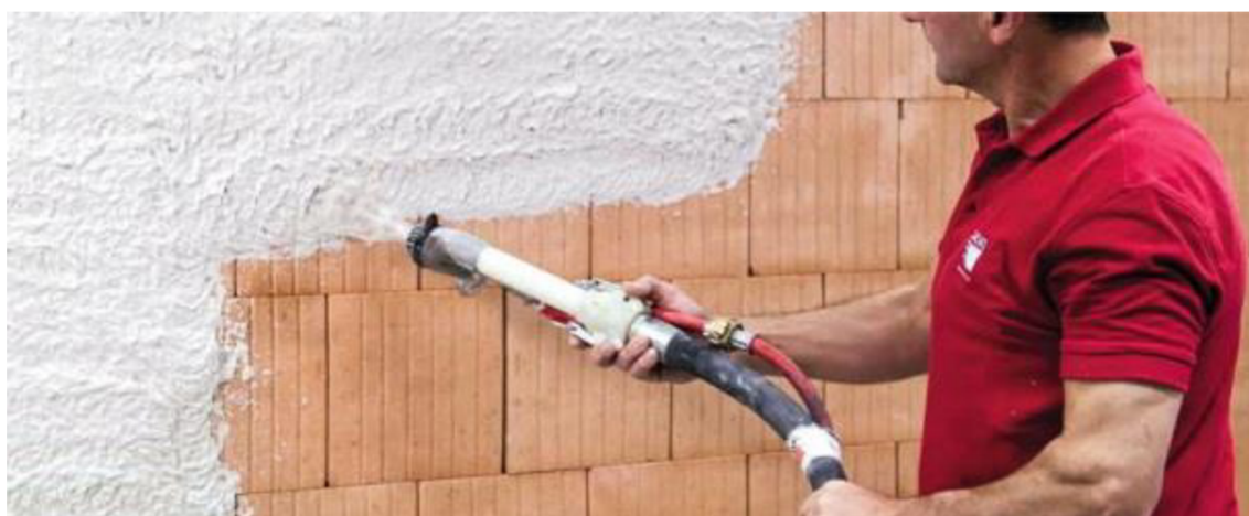
Obrázek 5: Aplikace tepelněizolační omítky [19]
