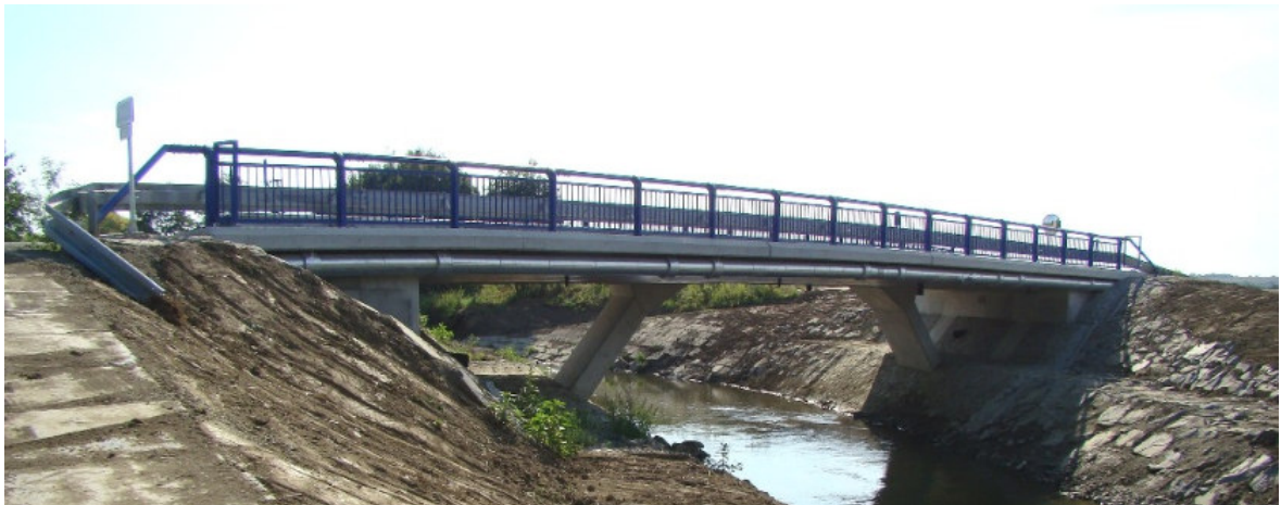
Obr. 2-7 Nová mostní konstrukce II [10]
