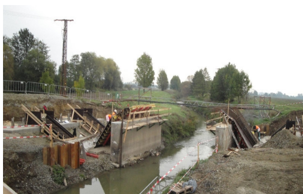
Obr. 2-9 Příprava na betonáž šikmých stojek [10]
