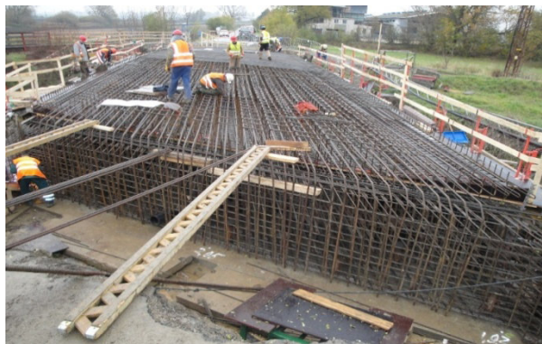
Obr. 2-8 Vyztužení nosné konstrukce [10]
