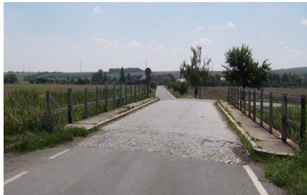
Obr. 2-2 Původní mostní konstrukce [10]
