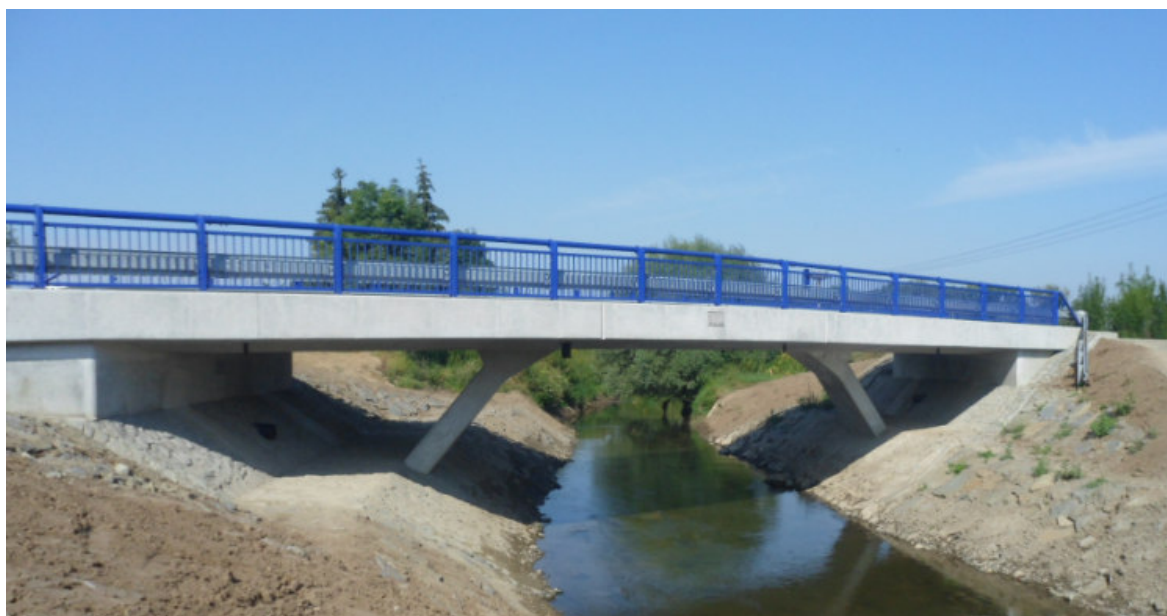
Obr. 2-6 Nová mostní konstrukce [10]
