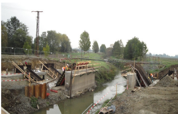
Obr. 2-9 Příprava na betonáž šikmých stojek [10]
