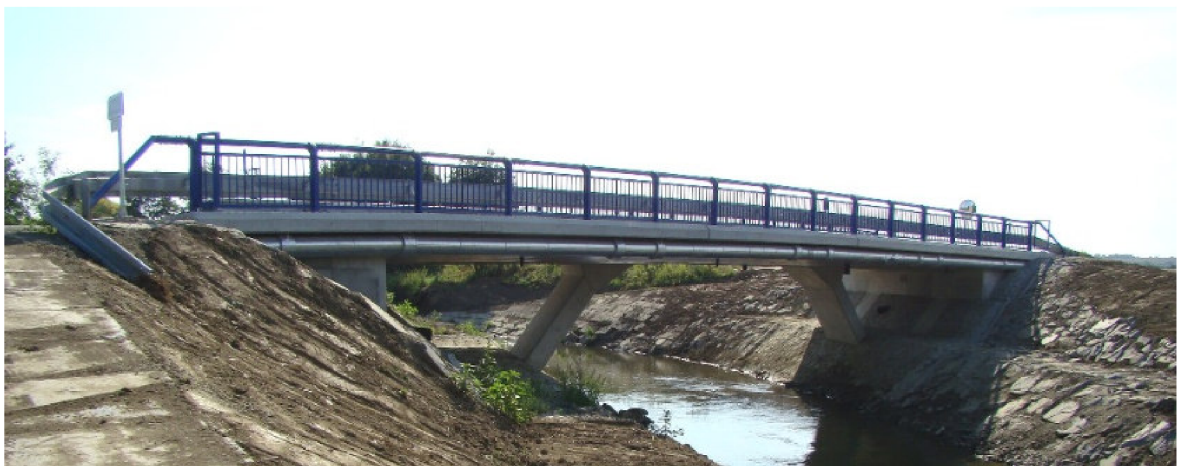
Obr. 2-7 Nová mostní konstrukce II [10]
