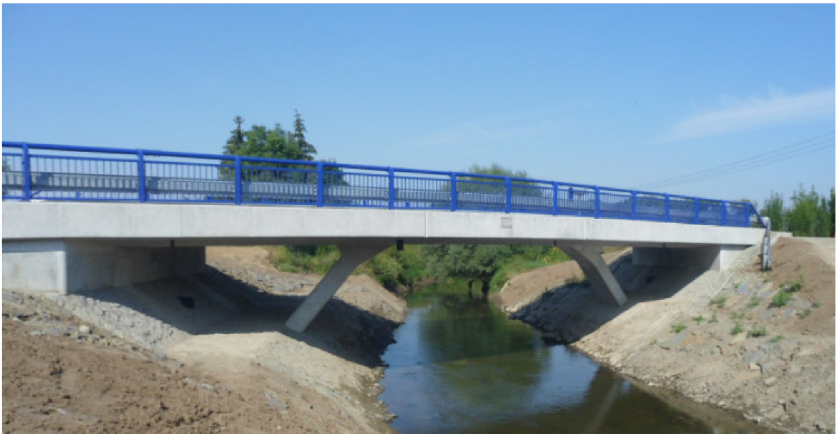
Obr. 2-6 Nová mostní konstrukce [10]
