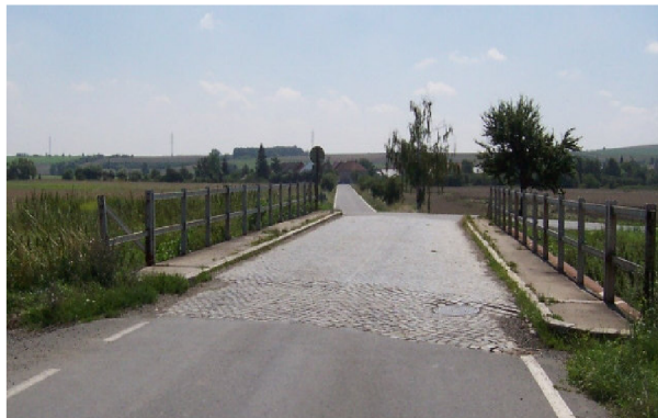
Obr. 2-2 Původní mostní konstrukce [10]
