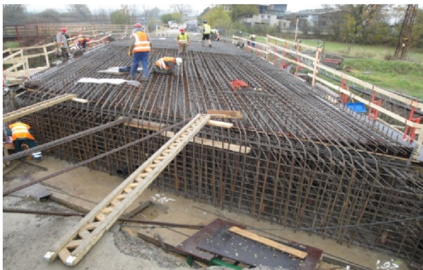
Obr. 2-8 Vyztužení nosné konstrukce [10]
