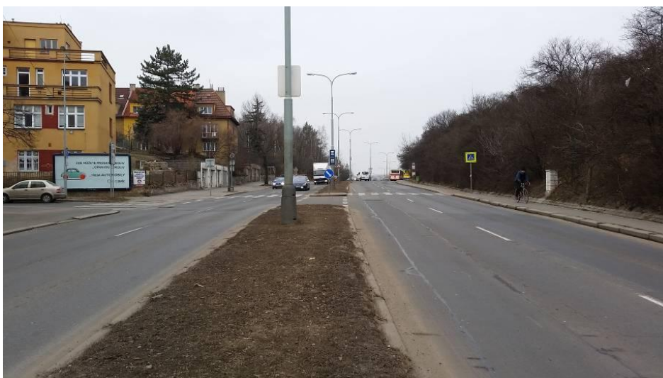
Přechod pro chodce - pohled ve směru k ul. K Žižkovu
