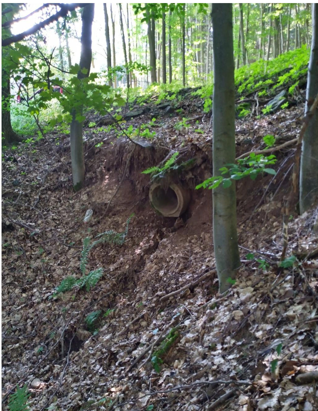
Obrázek č. 4-4 Stávající propustek na lokalitě č 3.
