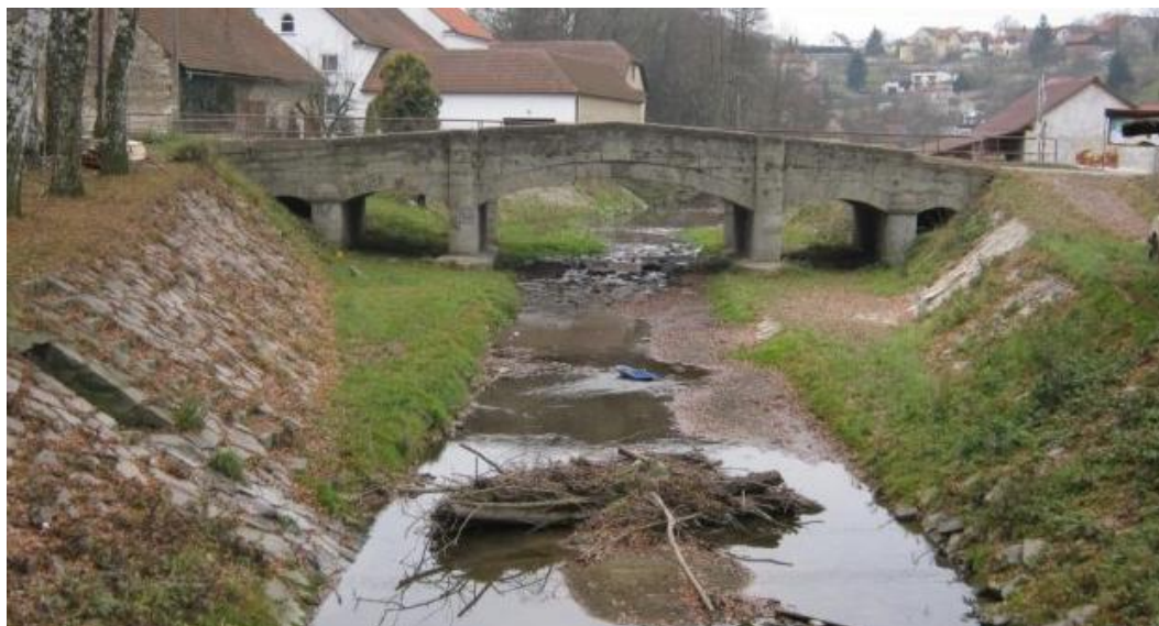
Obrázek 3-20 Splávy v korytě toku. Zdroj: https://www.edpp.cz/dou_fotodokumentace/
