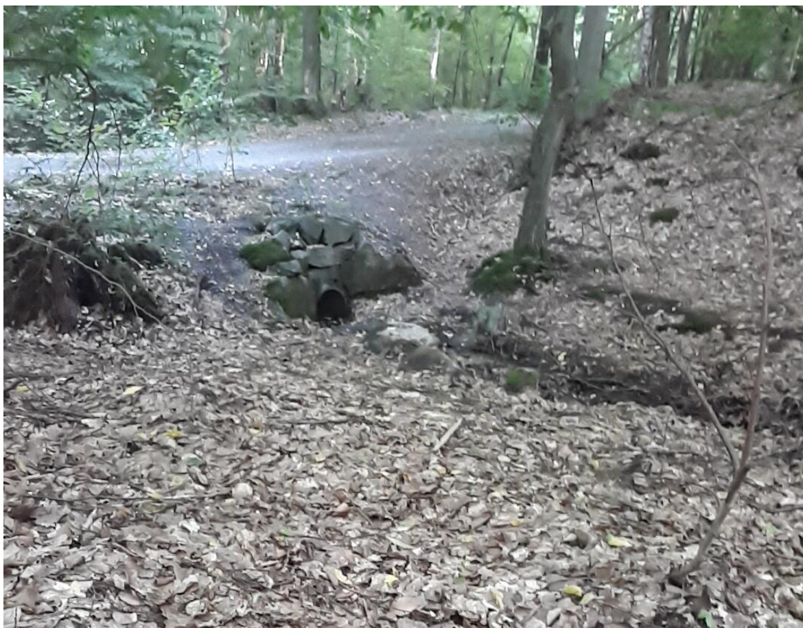
Obrázek 5-1 Fotografie stávajícího objektu na lokalitě č.1.
