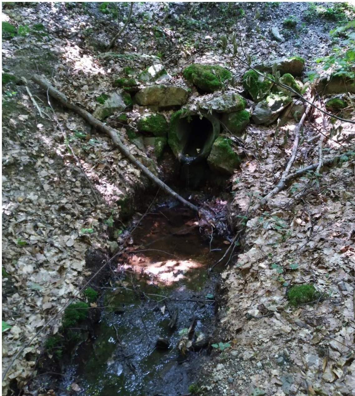
Obrázek č. 4-2 Stávající propustek na lokalitě č. 1.
