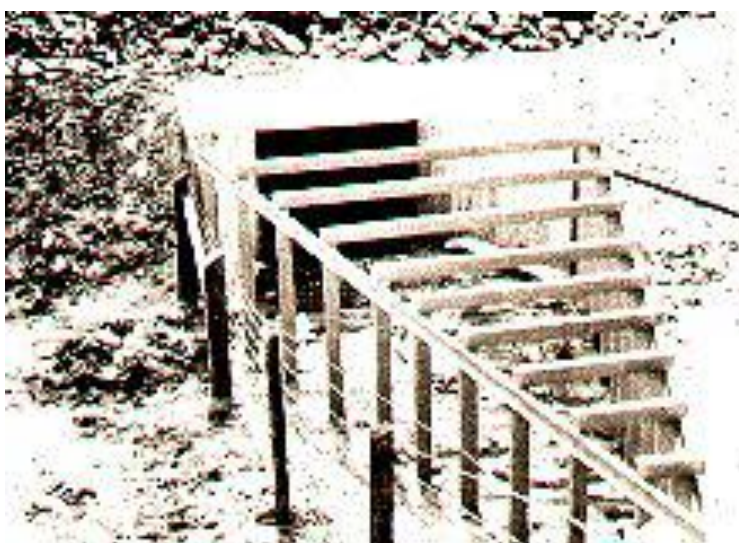
Obrázek 3-21 Deflektor spláví. Zdroj: TP 232
