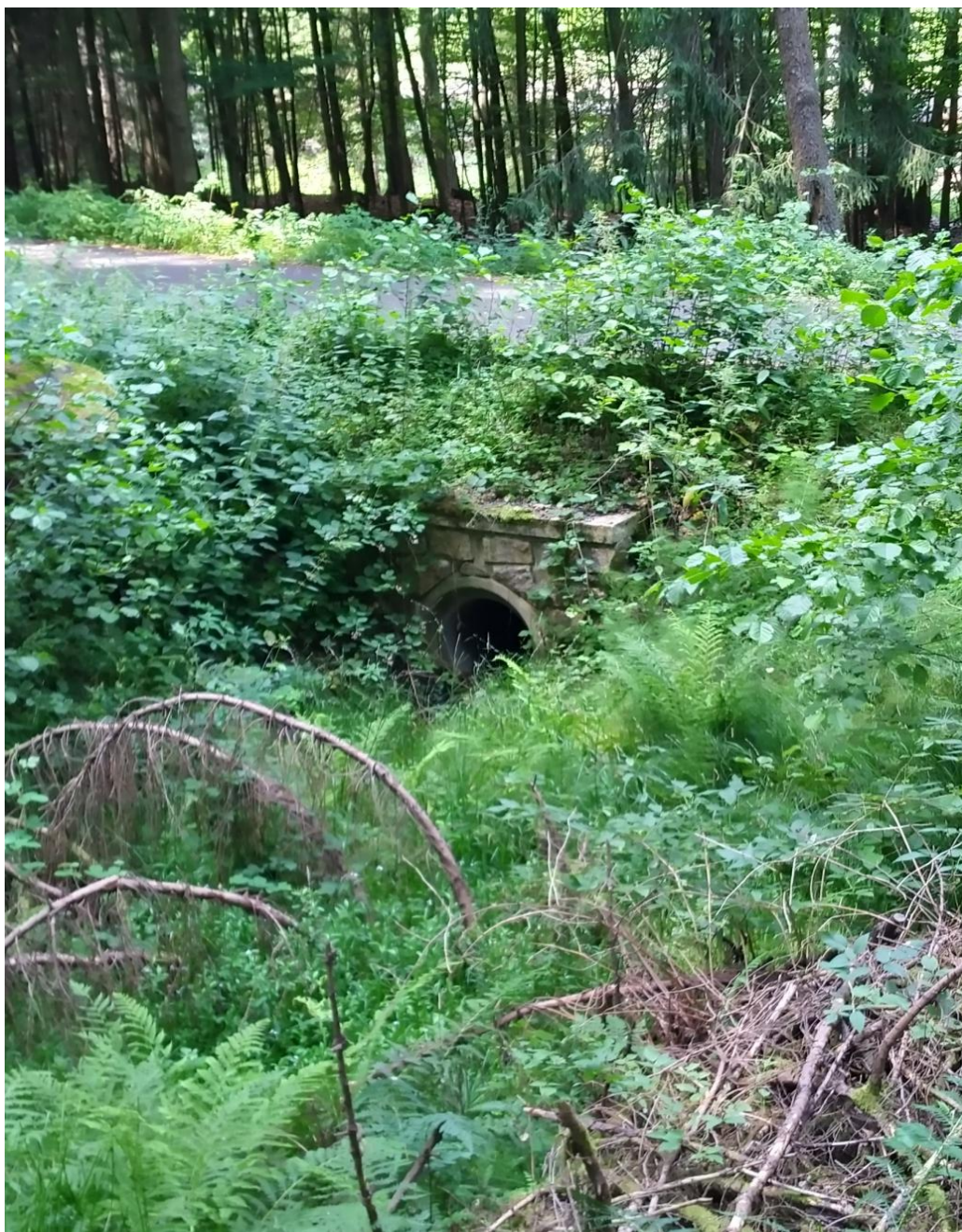
Obrázek č. 4-3 Stávající propustek na lokalitě č. 2.
