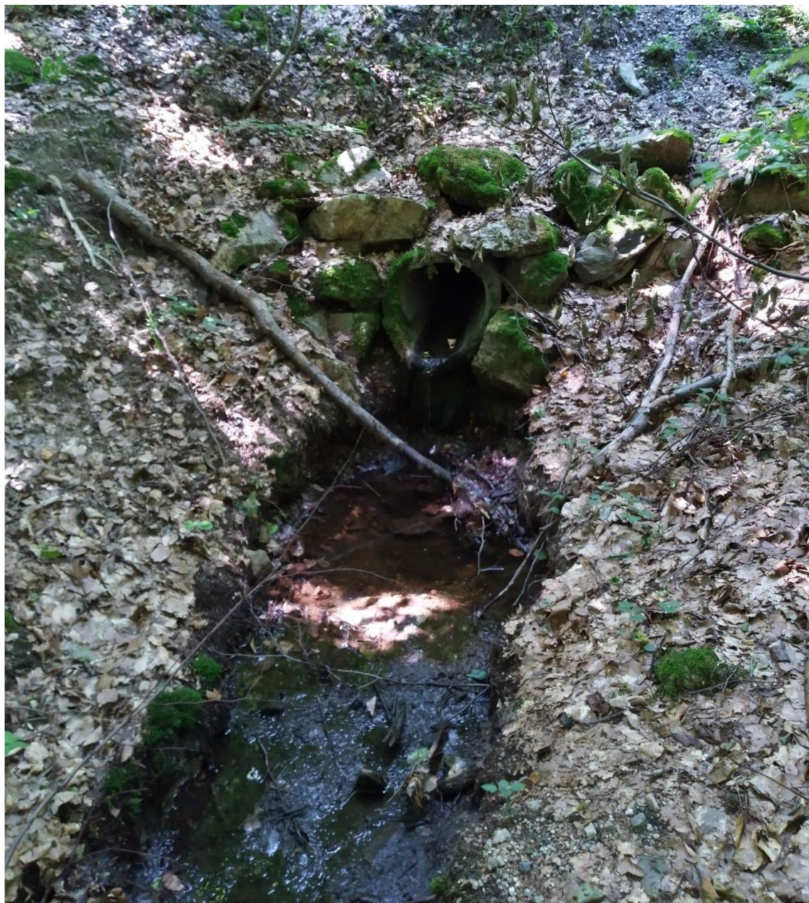
Obrázek č. 4-2 Stávající propustek na lokalitě č. 1.
