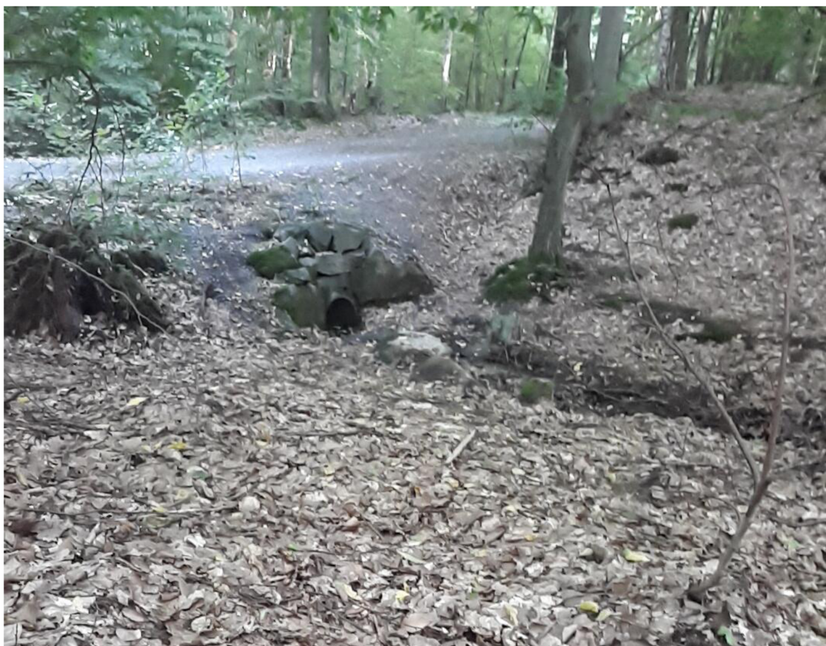
Obrázek 5-1 Fotografie stávajícího objektu na lokalitě č.1.
