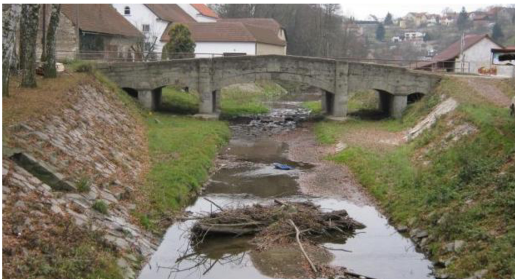
Obrázek 3-20 Splávi v korytě toku. Zdroj: https://www.edpp.cz/dou_fotodokumentace/
