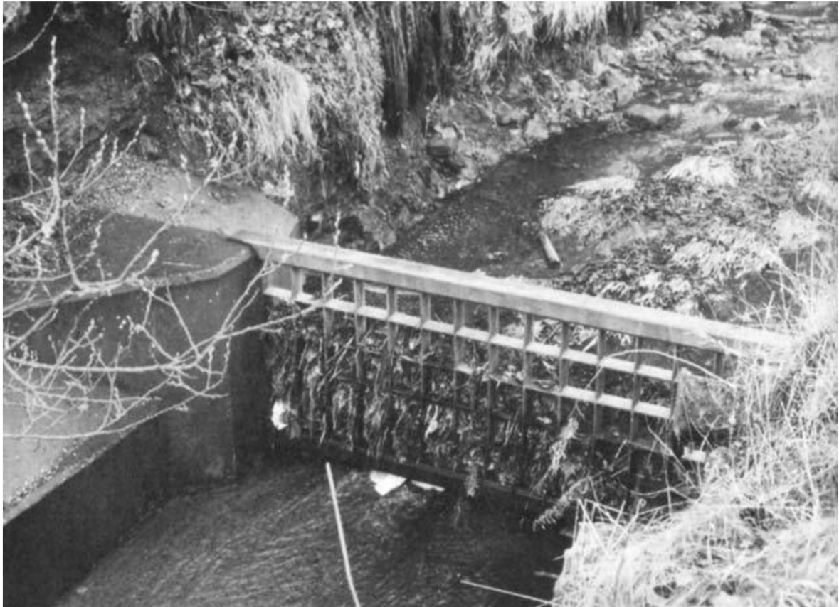
Obrázek 3-22 Konstrukce pro zachycení splávi nad propustkem. Zdroj: Culvert design and operation guide Figure 5.3
