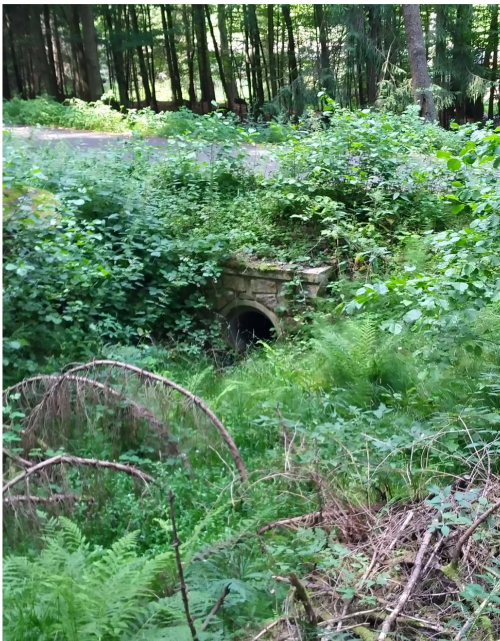
Obrázek č. 4-3 Stávající propustek na lokalitě č. 2.
