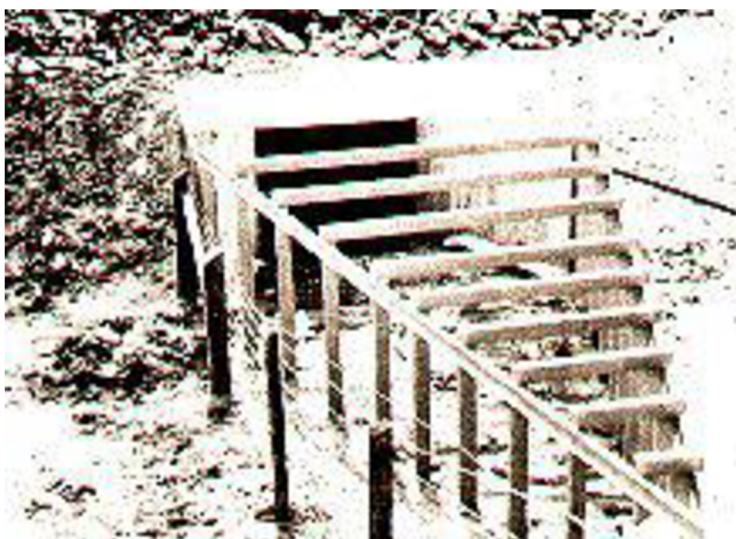
Obrázek 3-21 Deflektor splávi. Zdroj: TP 232
