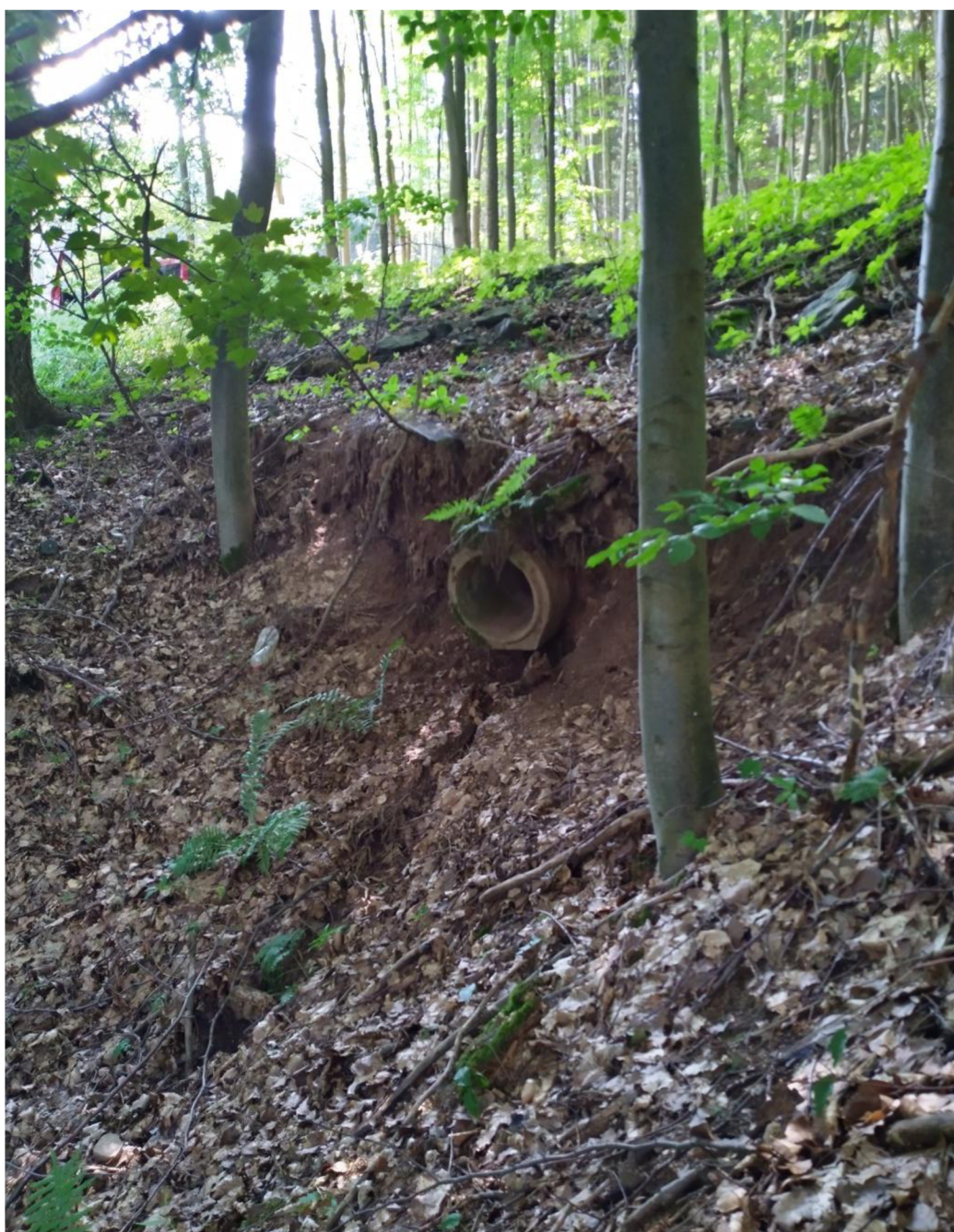
Obrázek č. 4-4 Stávající propustek na lokalitě č 3.
