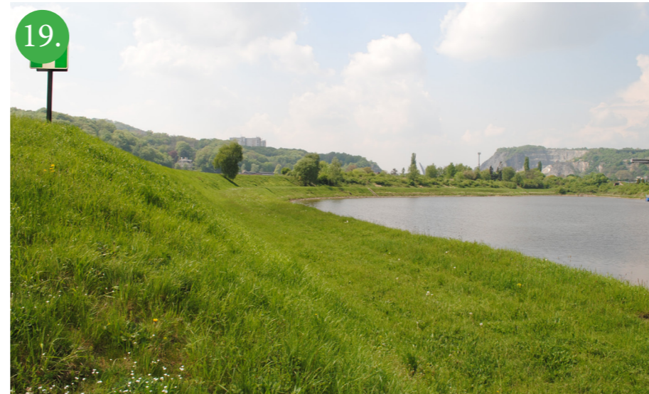
19. Plocha zálivu východního přístavu. Je zde patrá linie, kterou tvoří koruna náspu. Vzhledem k omezenému provozu východního přístavu se jedná o příjemnou klidovou lokalitu poloostrova, která je chráněna náspem.
