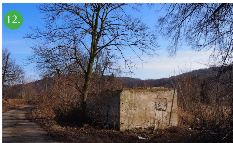
12. Budova B na mapě současného stavu. Zbytky budovy se nachází vedle budovy A. Objekty byly pravděpodobně zničeny během povodní v roce 2002, od té doby již nebyly obnoveny.
