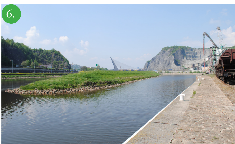
6. Na fotografii jsou patrné symboly města Mariánský most, Mariánská skála - přírodní památka s kamenolomem a průmysl. Hrana nábřeží je tvořena štětovou dlažbou. V této oblasti jsou stále funkční železniční koleje patřící k západnímu přístavu.
