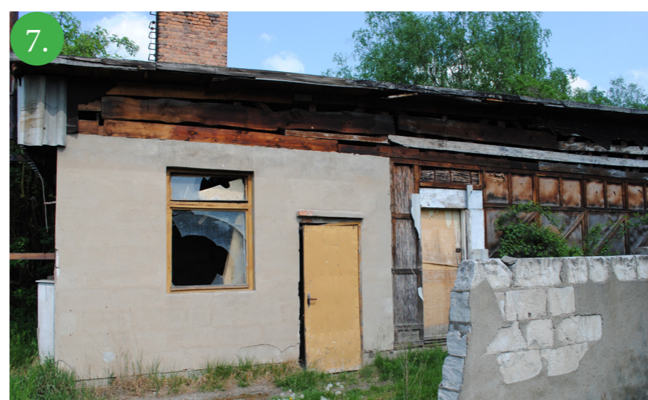
7. Dvě jednopodlažní budovy s dřevěnou nosnou konstrukcí, částečně dozděnou tvárnici a opláštěnou plechem. Zdevastovaná budova bývalé ubytovny dělníků východního přístavu se nachází v těsné blízkosti zahrádkářské kolonie.
