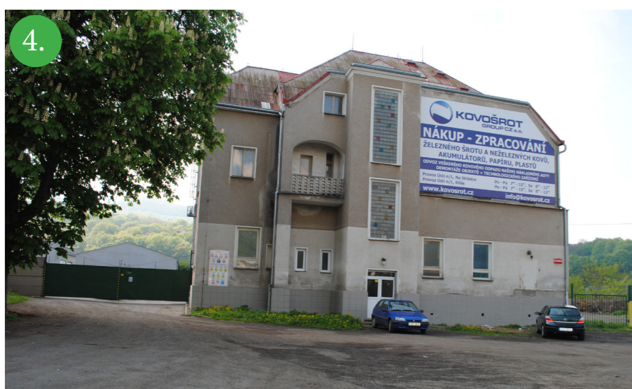
4. Objekt budovy kovošrotu. Před budovou je poměrně rozlehlé parkoviště. Objekt kovošrotu je oplocen betonovým plotem.
