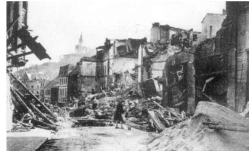
Obr. 40 Fotografie dubnových náletů na Ústí nad Labem. Dostupné z: < http://www.ceskestredohori.cz/ >
