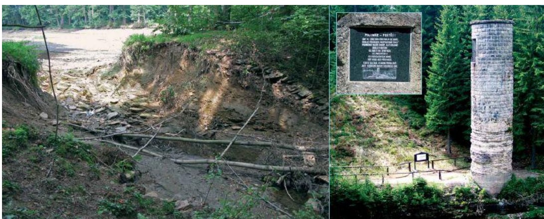
Obrázek č. 1: Zvláštní povodně, pozůstatky hráze přehrady Bílá Desná. (www.chmi.cz)
