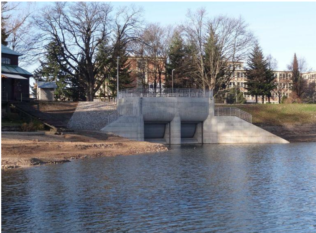
Obrázek č. 15: Vtokový objekt nové protipovodňové štoly. ( www.mestojablonec.cz )
