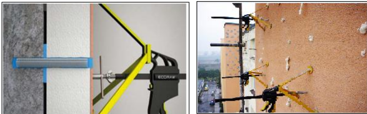
Obr. 14: Sanace nestabilního zateplení pomocí injektovaného kotvení 64, 65
