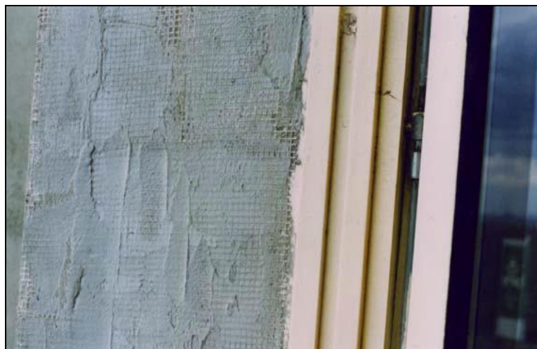
Obr. 4: Špatné krytí sítoviny stěrkovou hmotou 51
