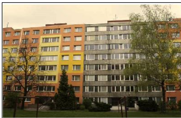
Obr. 7: Panelový dům typu T08B 65
