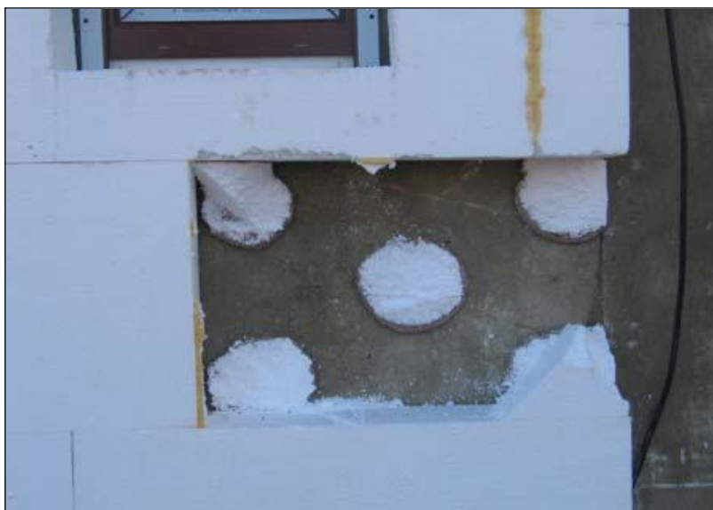
Obr. 2: Ukázka špatného nanesení lepicí hmoty na desku z EPS 51
