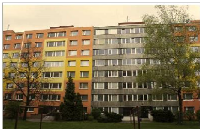
Obr. 12: Panelový dům typu T08B, rozměry 65
