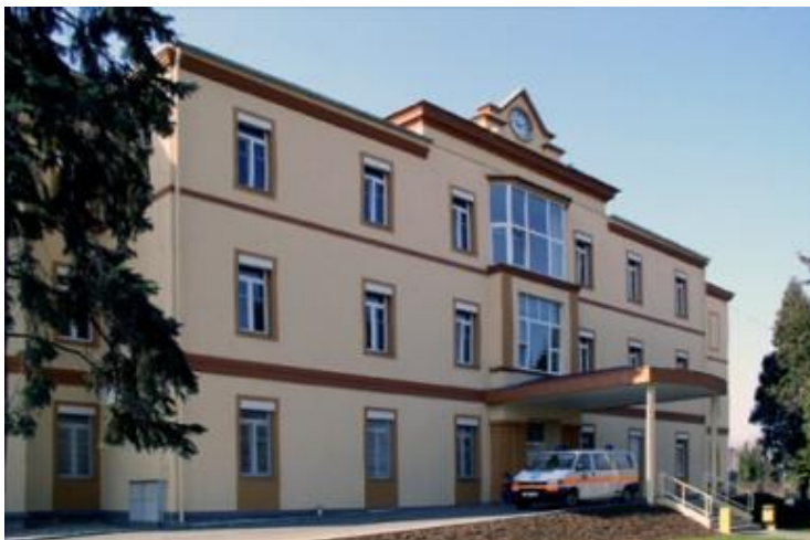
Obr. 16: Nemocnice ve Šternberku
