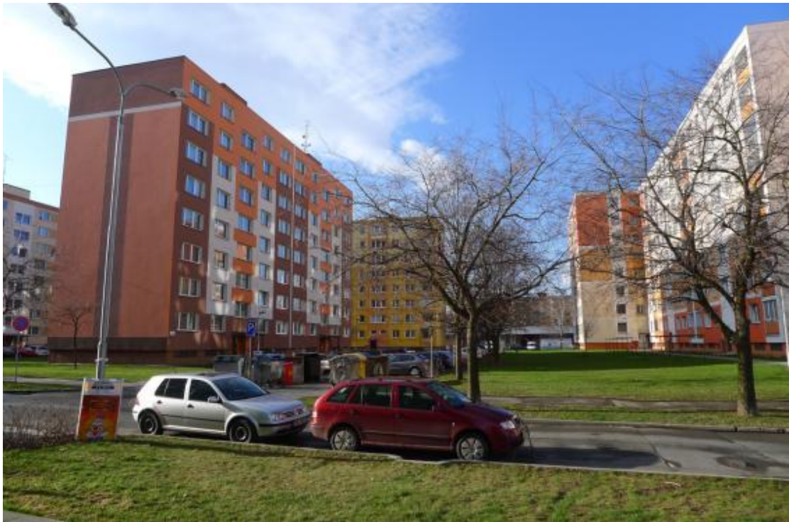
Obr. 45. Sídliště Nové Sady, zdroj: archiv autorky
