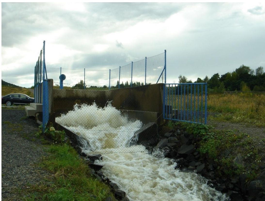
Obr. č. 12: Uklidňovací objekt u Mosteckého jezera (originál)
