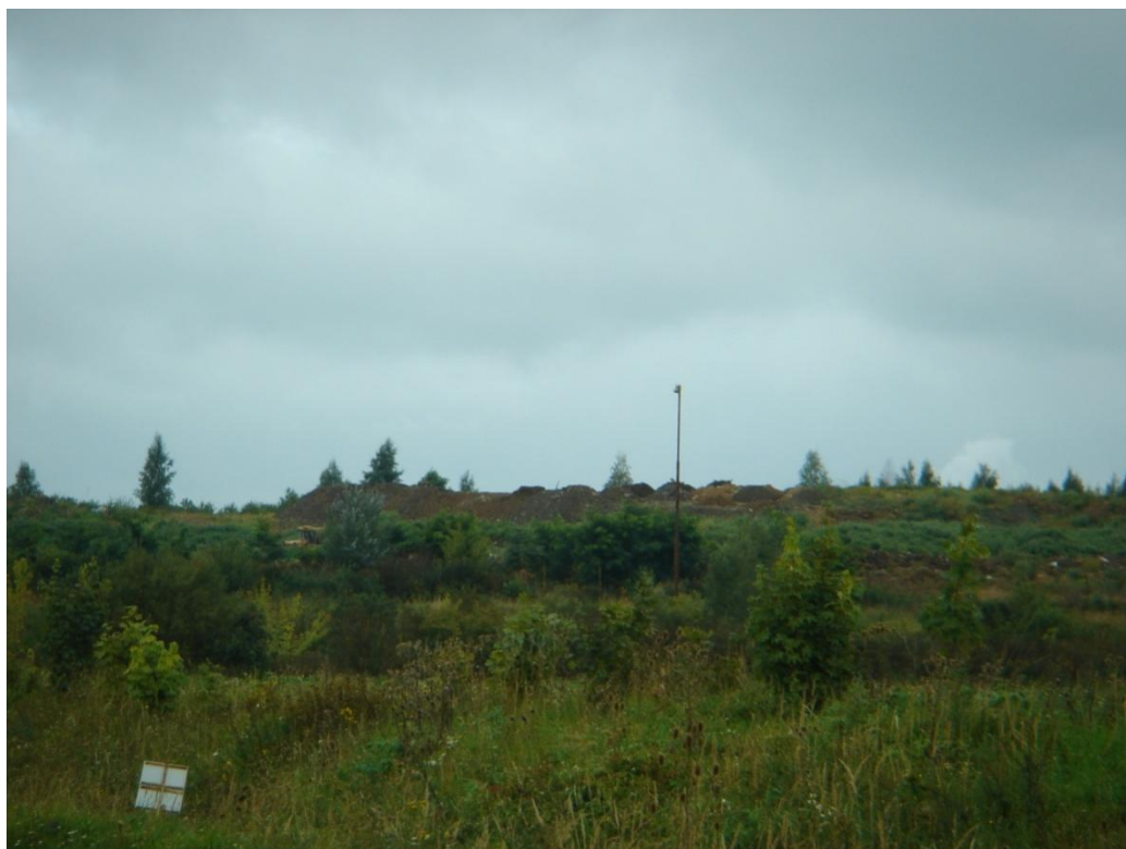
Obr. č.16: Kompostárna Střimice – pohled od Mosteckého letiště (originál)
