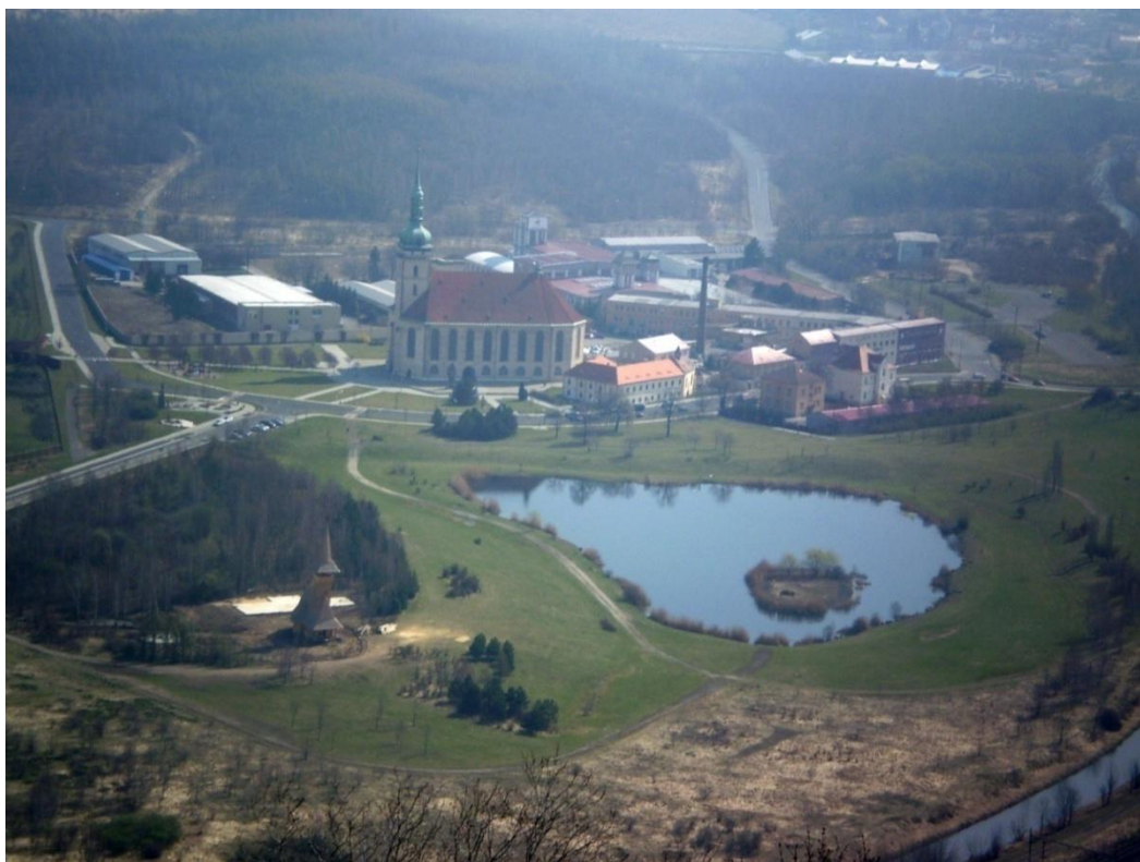
Obr. č. 40: Parkové úpravy kolem kostela Nanebevzetí Panny Marie v Mostě (originál)
