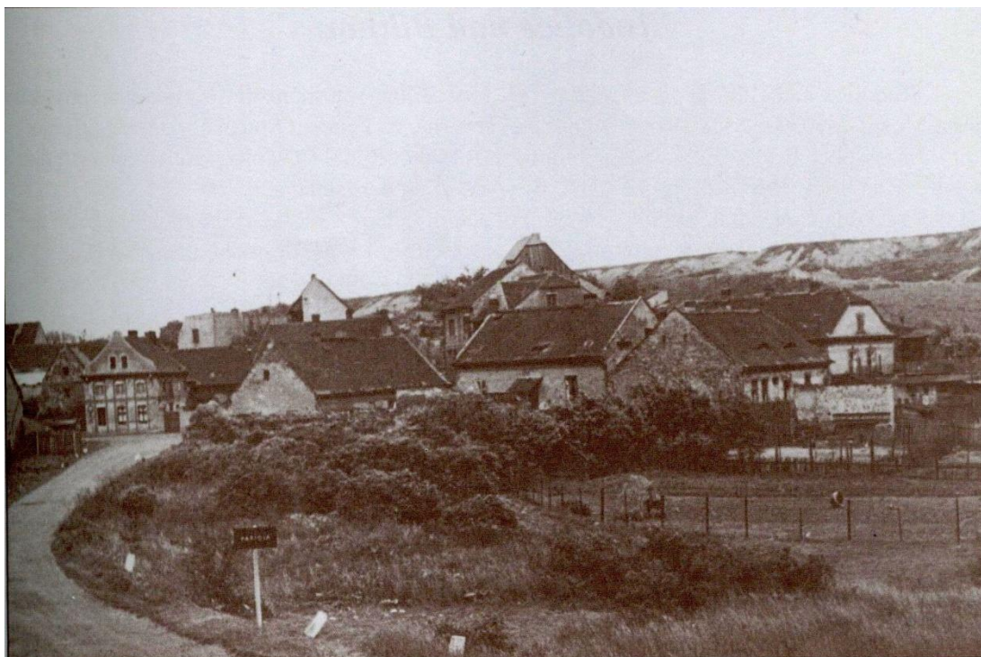
Obr. č. 31: Část obce před likvidací v 60. letech 20. století (Sýkorová J. 2002)
