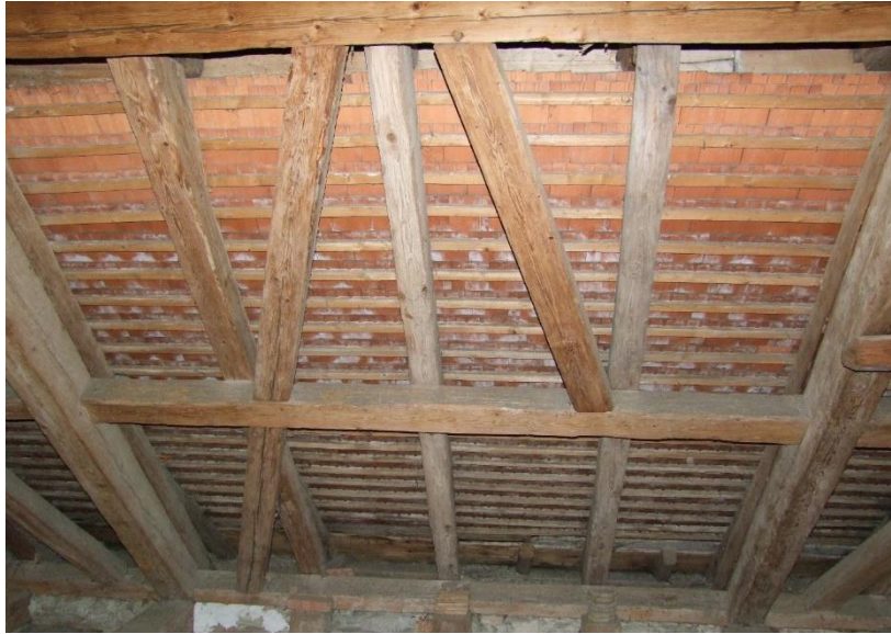
Obrázek 20 Ztužení v podélném směru vaznicí, vzpěrami a laťováním
