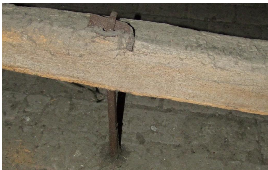
Obrázek 22 Závlač zajištěná kovaným klínem
