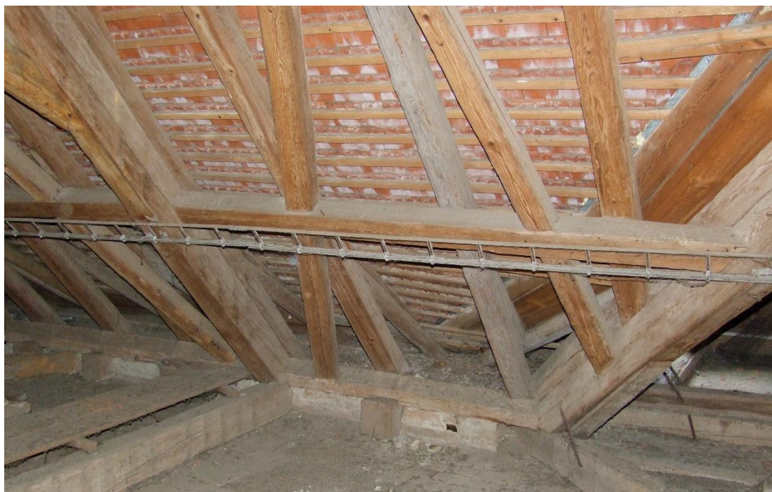
Obrázek 18 Zazdění vazních trámů
