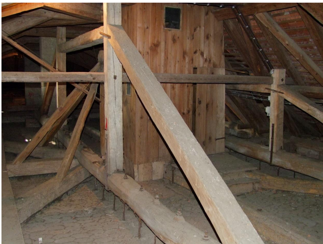
Obrázek 17 Konstrukce dvojitého věšadla a konstrukce nesoucí hodinový stroj
