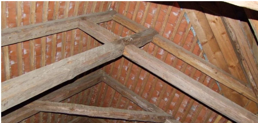
Obrázek 21 Ztužení konstrukce ondřejskými kříži nebo hambálkem
