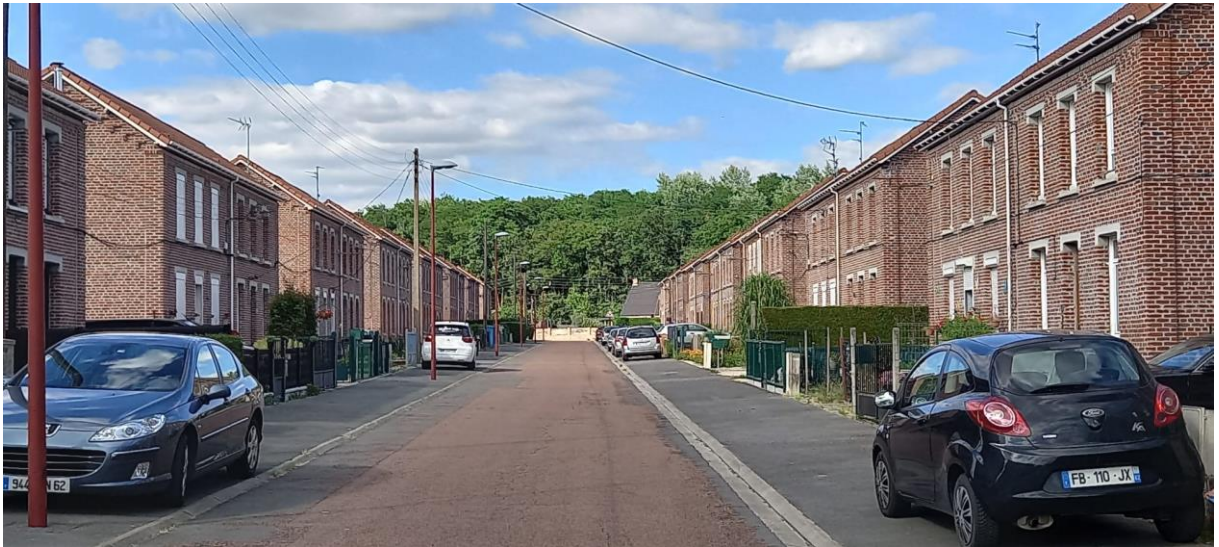
Figure 5 : Coron de Leforest en briques rouges réhabilité, Pas-de-Calais (62)
