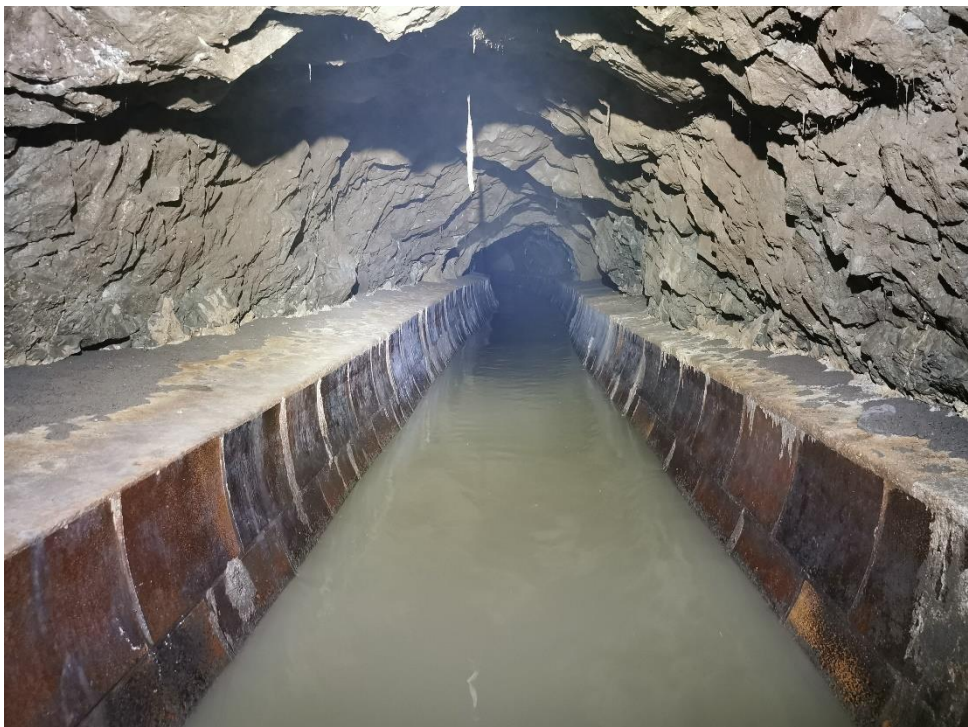
Obr. 3-28 – úsek kmenové stoky v hornině bez ostění – pod Mariánskou skálou [zdroj: Lukáš Havlíček]
