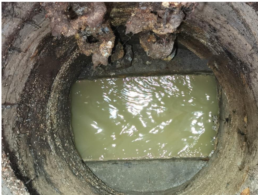
Obr. 5-11 – šachta na hlavní stoce DN 600 těsně před čerpací stanicí Červený mlýnek [zdroj: Lukáš Havlíček]
