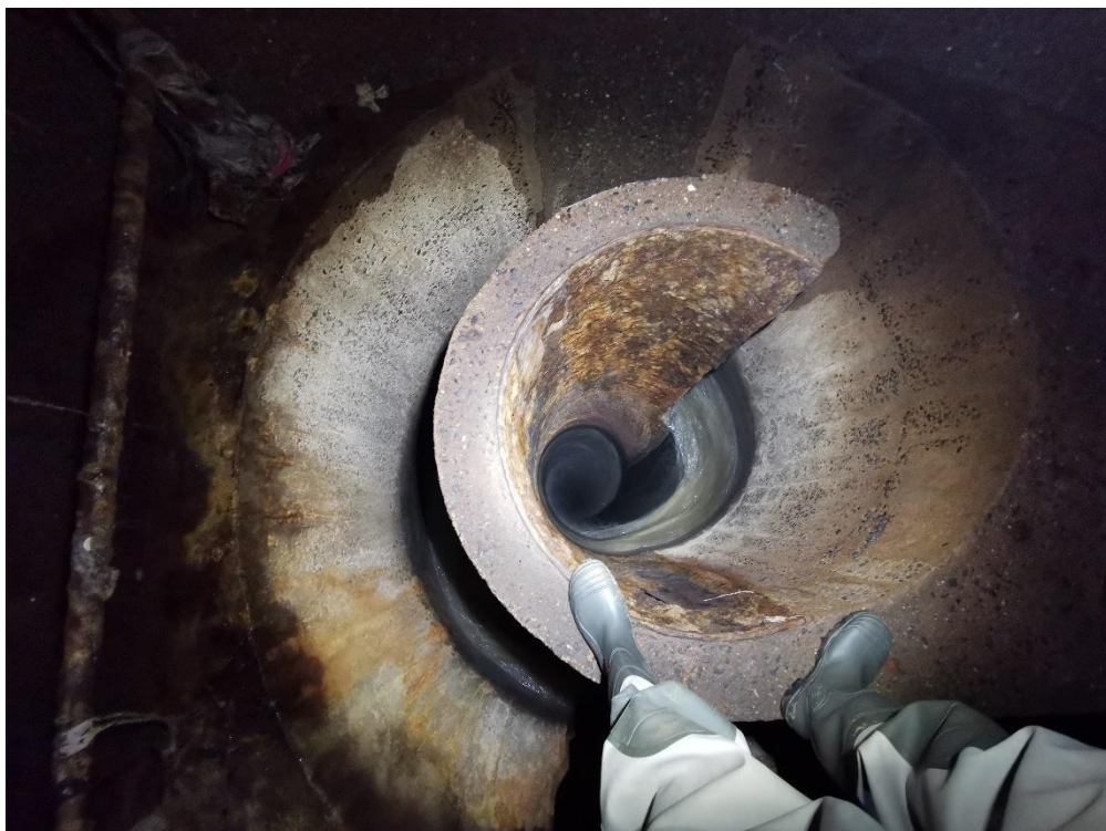
Obr. 3-25 – pohled do spadiště s tangenciálním nátokem stoky C [zdroj: Lukáš Havlíček]
