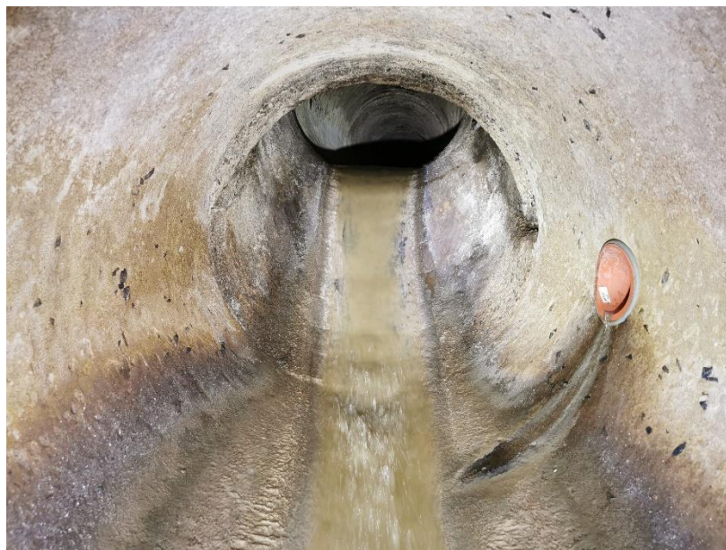
Obr. 4-25 – pohled na jeden ze skluzů na kmenové stoce [zdroj: Lukáš Havlíček]
