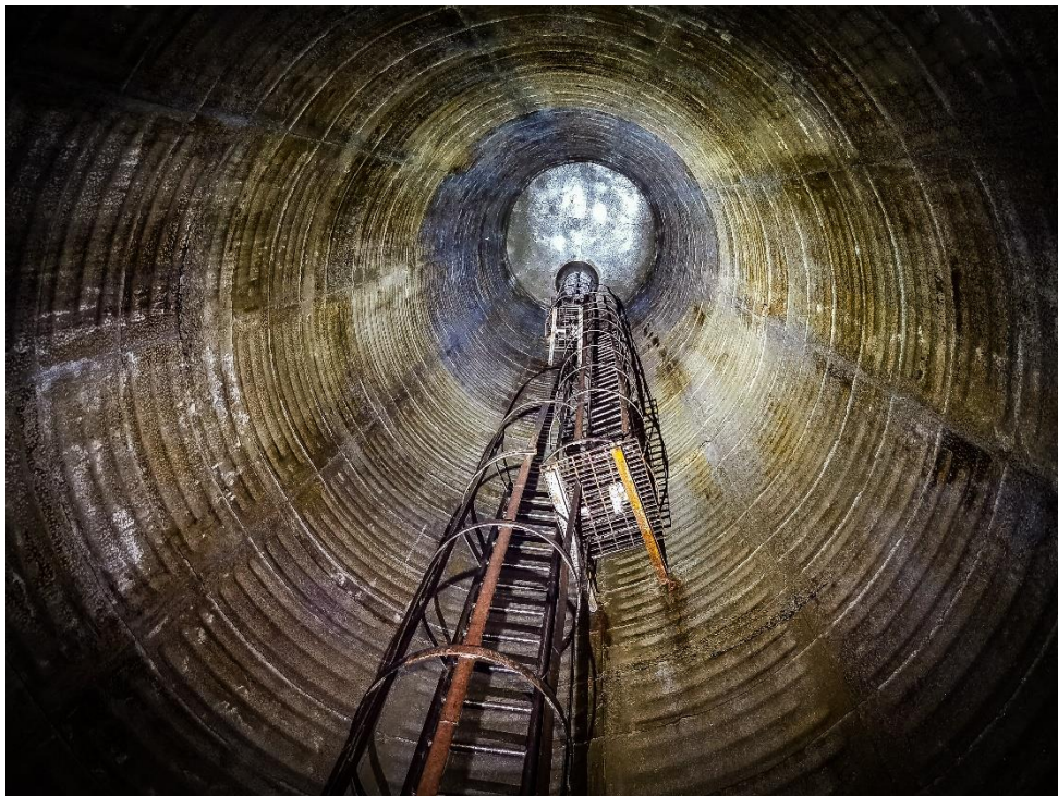
Obr. 3-20 – pohled na typickou šachtu na sběrači B [zdroj: Lukáš Havlíček]
