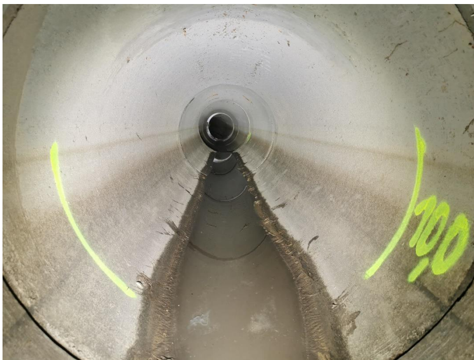
Obr. 7-1 pohled do dešťové stoky DN 800 v ulici Chřibská ve starých Ďáblicích a na splaškový průtok [zdroj: Lukáš Havlíček]
