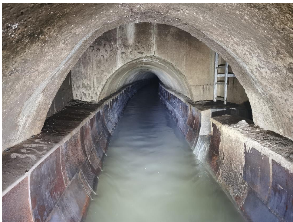
Obr. 3-29 – vstupní šachta 17 a betonové ostění [zdroj: Lukáš Havlíček]
