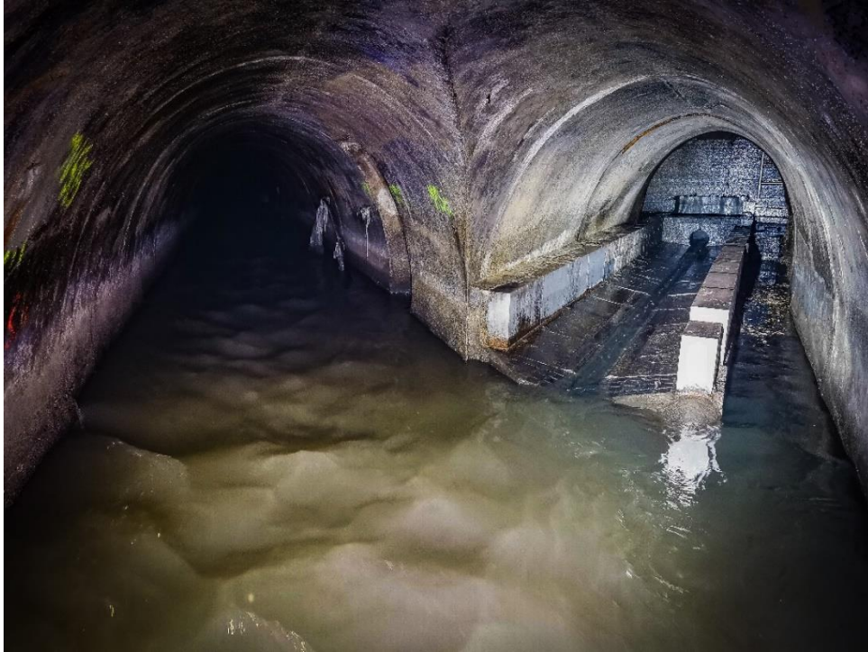
Obr. 3-19 – pohled do štoly sběrače B a na rozrážku přítoku [zdroj: Lukáš Havlíček]
