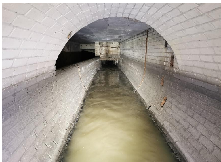
Obr. 5-16 – pohled do oddělovací komory na stoce DN 2000 u ulice Na Barikádách [zdroj: Lukáš Havlíček]
