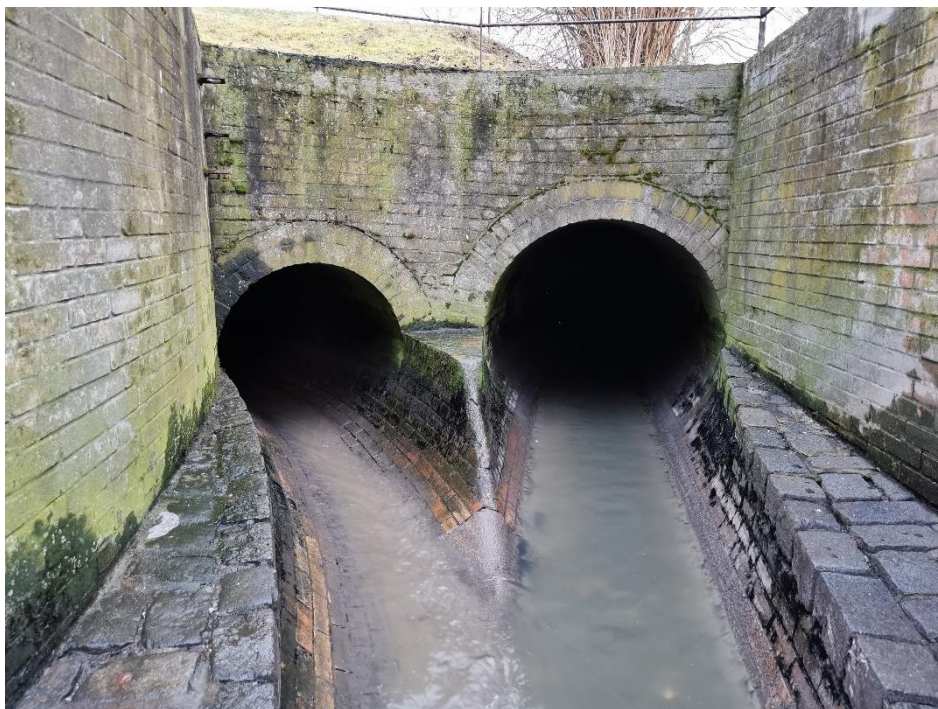
Obr. 5-20 – pohled na spojnou komoru v areálu ČOV – přímá je stoka DN 1600 ze Kbel, v oblouku se připojuje profilem DN 1200 stoka ze Satalic [zdroj: Lukáš Havlíček]
