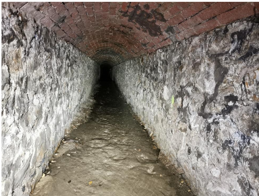
Obr. 4-26 – pohled do dešťové stoky – patrný splaškový průtok [zdroj: Lukáš Havlíček]
