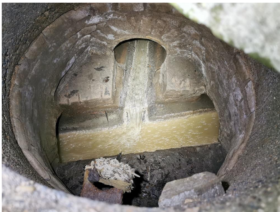
Obr. 4-22 – pohled do spojné šachty hlavní stoky a stoky z oblasti kolem ulic Na Vinici, Na Hradišti a U Háje [zdroj: Lukáš Havlíček]
