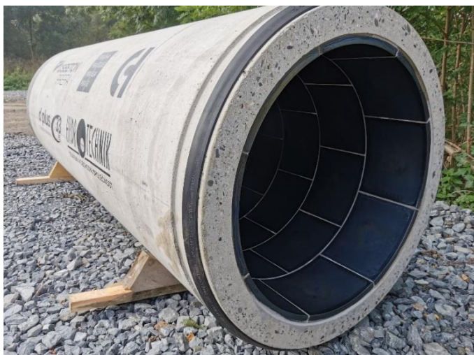
Obr. 3-14 – pohled na železobetonovou troubu s celočedičovým obkladem na stavbě protlaku sběrače H2 v Běchovicích [zdroj: Lukáš Havlíček]
