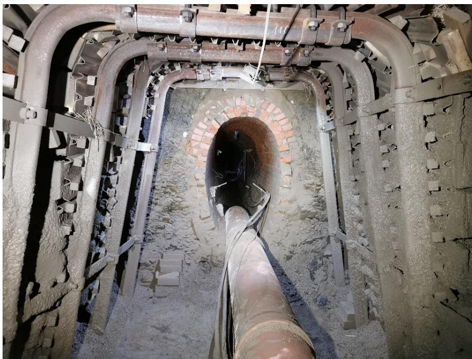
Obr. 3-2 – pohled na přeražbu stoky v ulici Prokopova klasickou ražbou [zdroj: Lukáš Havlíček]
