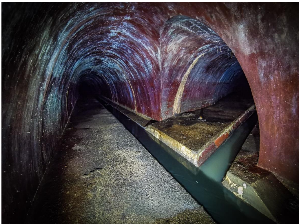
Obr. 3-22 - pohled na napojení přívaděče Hradiště na hlavní štolu [zdroj: Lukáš Havlíček]
