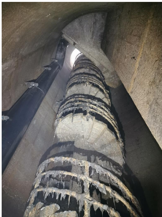
Obr. 3-26 – pohled na vstupní schodiště do štoly [zdroj: Lukáš Havlíček]
