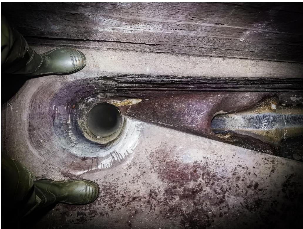
Obr. 3-23 – pohled na spadiště přípojně stoky do sběrače [zdroj: Lukáš Havlíček]
