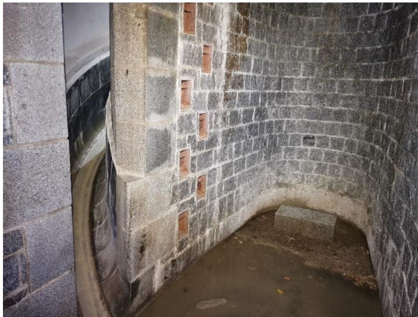
Obr. 4-15 – pohled na spadiště s tangenciálním obtokem v ulici Nad Novou Libní [zdroj: Lukáš Havlíček]
