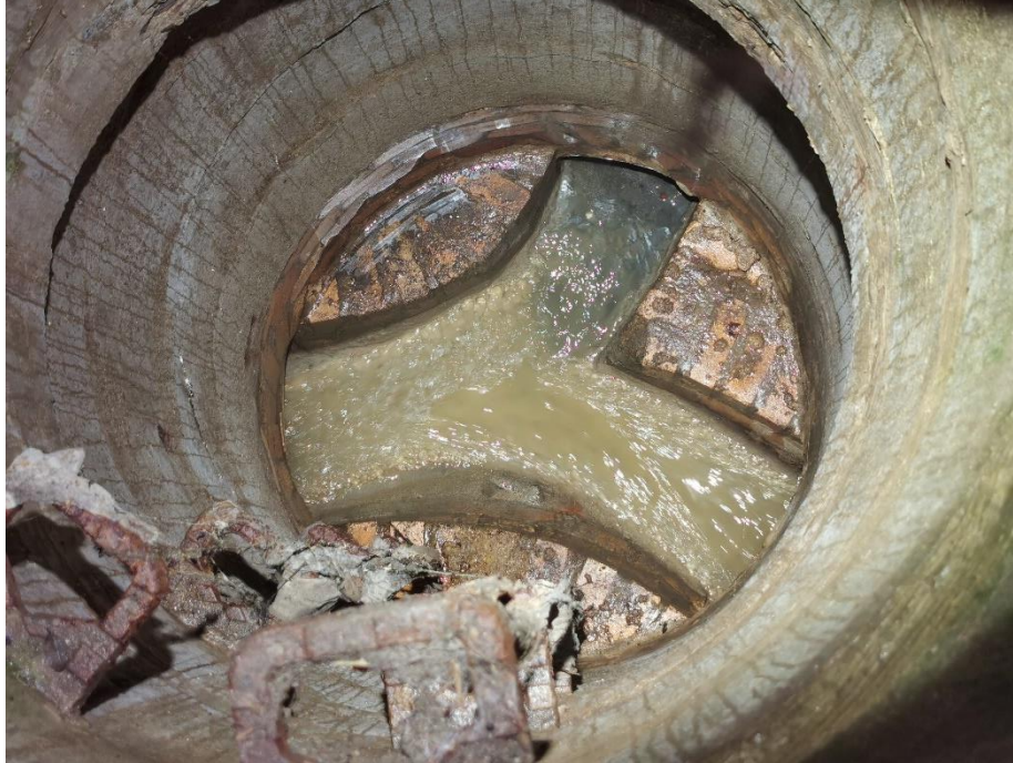
Obr. 5-5 – pohled do hlavní stoky DN 400 a na přítok DN 300 v ulici K Drahani – 400 m před nátokem na ČOV [zdroj: Lukáš Havlíček]
