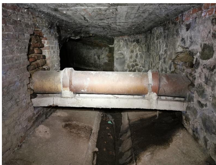
Obr. 4-18 – pohled na vzájemné křížení stok a netěsnosti splaškové stoky křížící stoku dešťovou [zdroj: Lukáš Havlíček]
