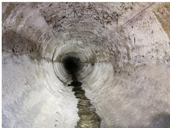
Obr. 4-17 – pohled do hlavní dešťové stoky (dříve výpusti) DN 1400 – patrný splaškový průtok [zdroj: Lukáš Havlíček]
