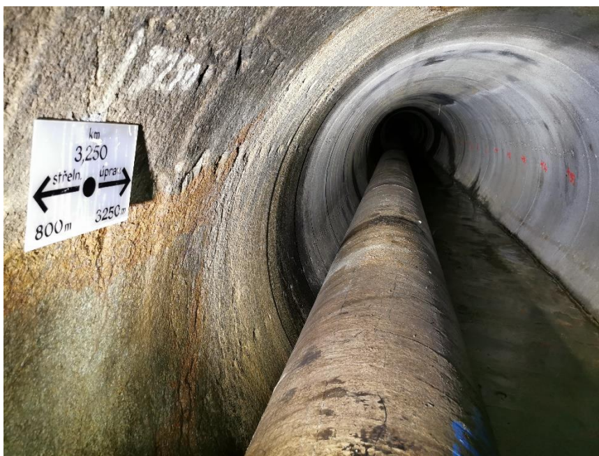
Obr. 3-10 – pohled na vrtaný vodovodní tunel Bedřichov – Liberec DN 2650 štítem Demag v neporušené hornině – liberecké žule [zdroj: Lukáš Havlíček]
