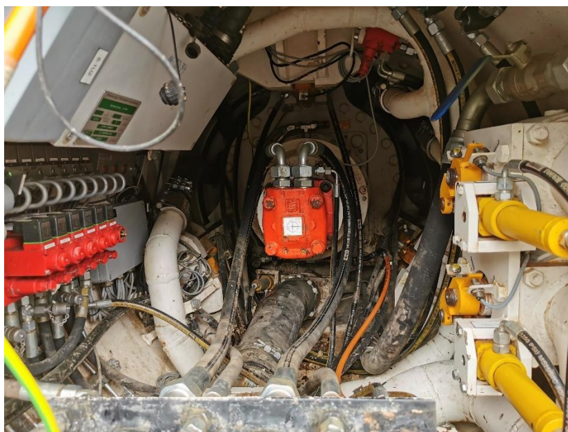
Obr. 3-12 – pohled do vnitřku razícího štítu a na umístění naváděcího štítku [zdroj: Lukáš Havlíček]
