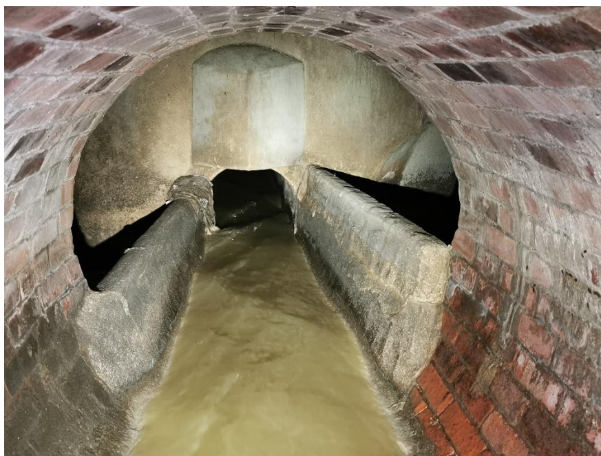
Obr. 5-17 – pohled do oddělovací komory na stoce DN 1200 před ČOV Miškovice [zdroj: Lukáš Havlíček]
