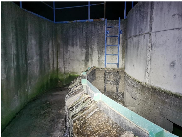
Obr. 4-14 – pohled na přepadovou hranu vírového separátoru [zdroj: Lukáš Havlíček]
