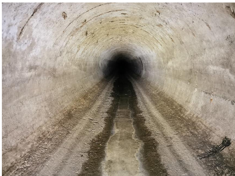
Obr. 4-9 – pohled do výpusti tlamového profilu [zdroj: Lukáš Havlíček]
