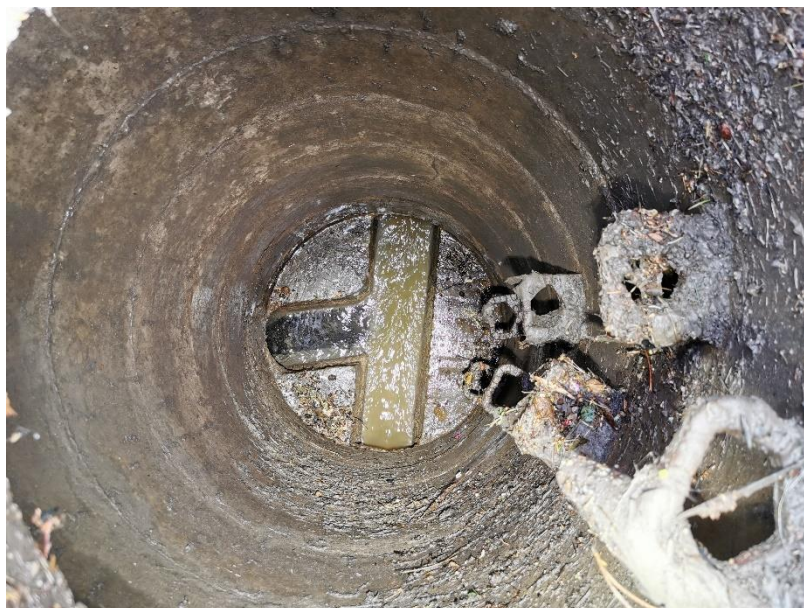
Obr. 5-8 – pohled do hlavní stoky v ulici Chřibská, vlevo přítok z ulice U Chaloupek [zdroj: Lukáš Havlíček]
