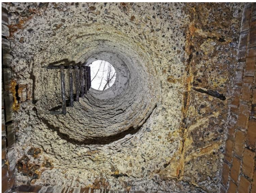
Obr. 7-3 – pohled na šachtu v ulici Žernosecká na stoce za vyústěním výtlačků z čerpací stanice Červený mlýnek [zdroj: Lukáš Havlíček]
