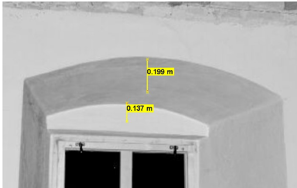
obr. 7.6 - ukázka TR Scan explorer Viewer, odměření výšky vzepětí klenby
