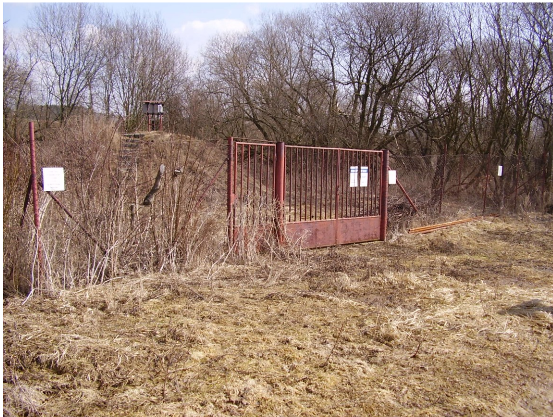
Obr. 2 - Vodní zdroj vrt HV-1 Litohlavy
