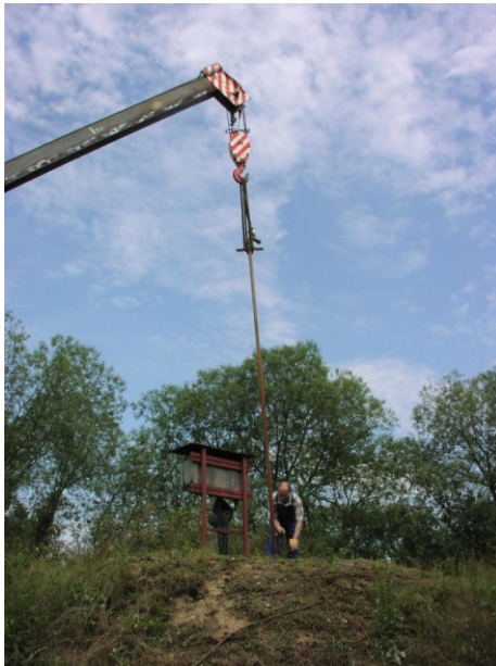
Obr. 3 - Demontáž ponorného čerpadla pomocí jeřábu
