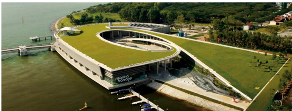
Obrázek 7 Marina Barrage Singapur (Urban green – blue grids 2020b)
