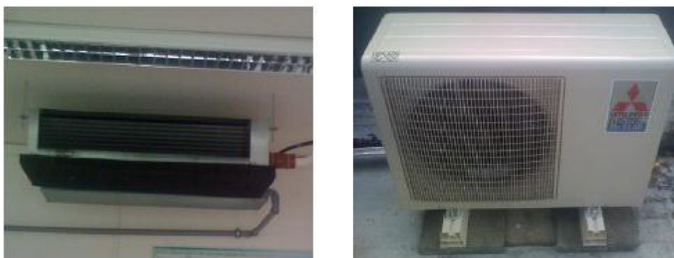
8.2 Vnitřní a vnější jednotka systému Mr. Slim
