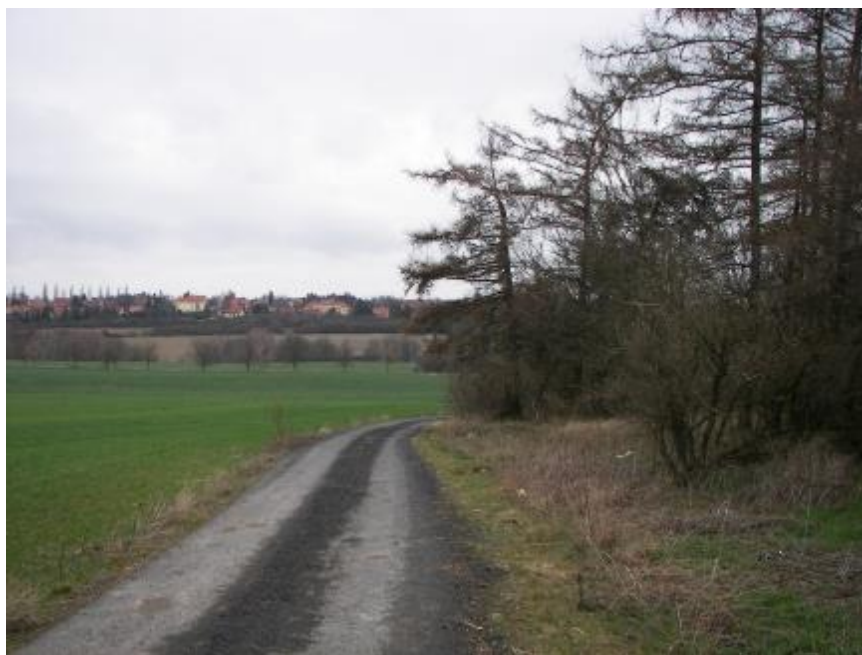
Foto č. 4 – rekonstruovaná polní cesta. Zdroj: Dagmar Maňasová 2/2016
