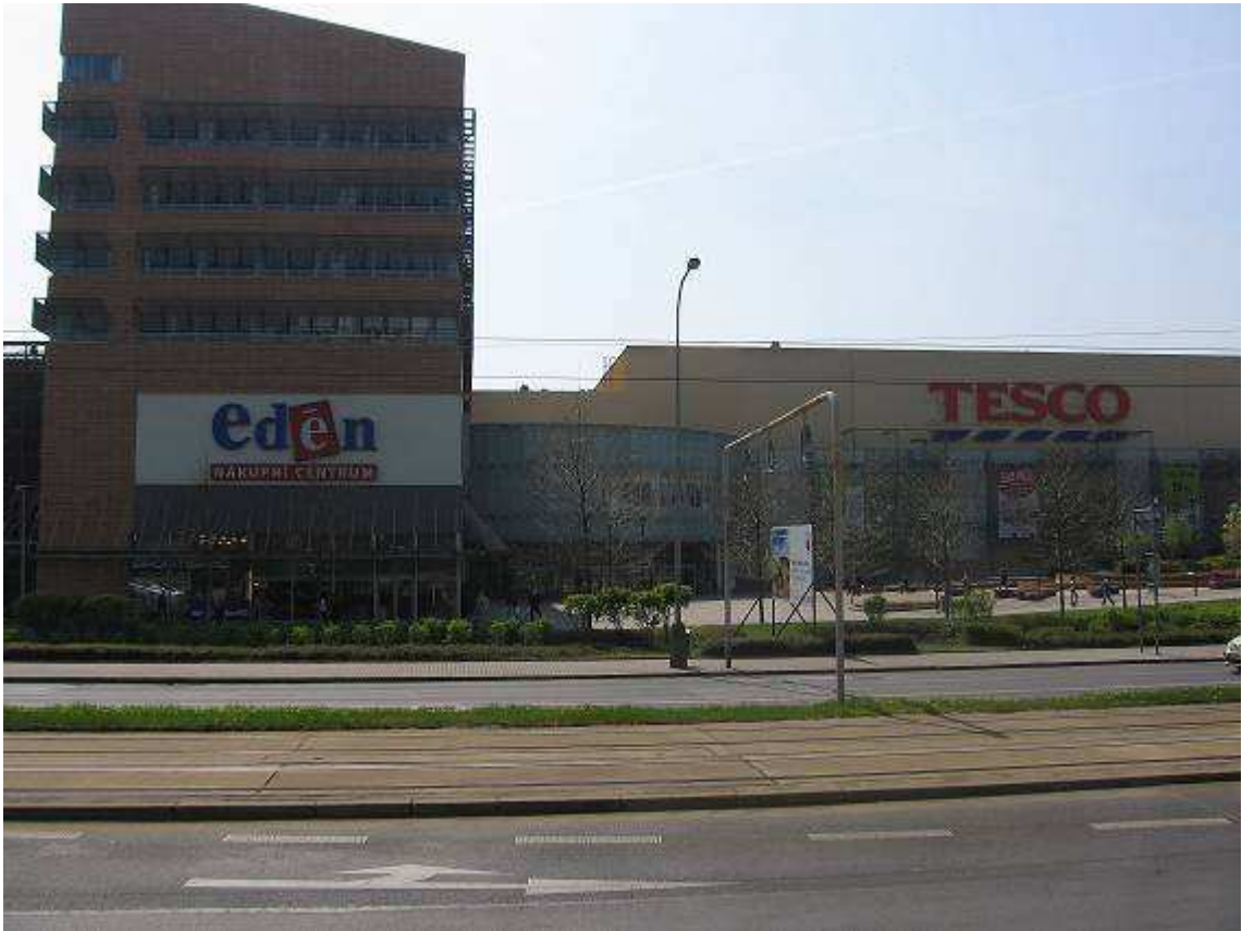
Obr. č. 20 pohled na celé nákupní centrum od budovy Ministerstva životního prostředí (foto autor práce)
