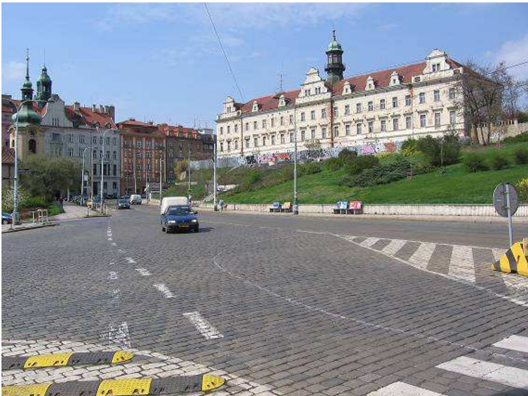
Obr. č. 10 Široká ulice a ustupující chodníky v pozadí chátrající budova Rangherka (foto autor práce)
