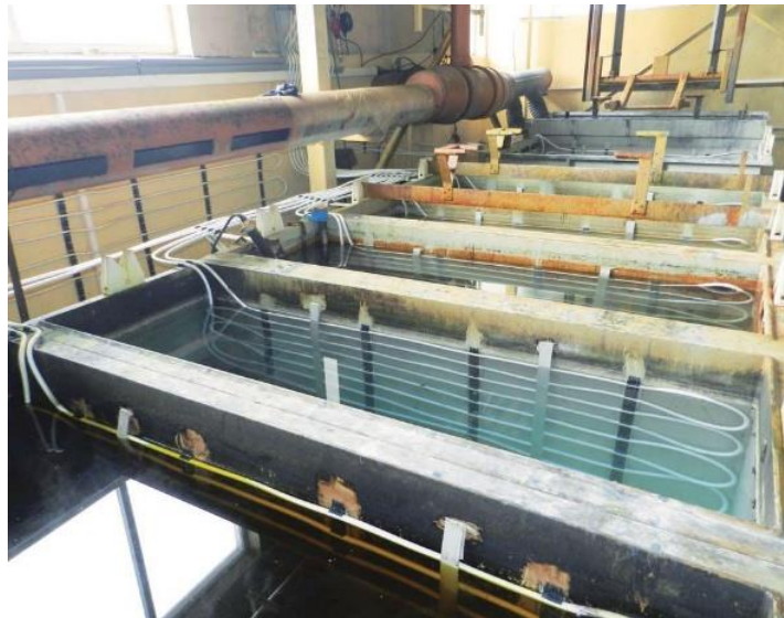
Obrázek 22. Lázně galvanovny, kde je instalováno průmyslové TČ. [24]
