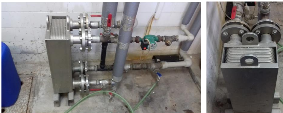
Obrázek 64. Deskový výměník pro ohřev vody na oplachy.
