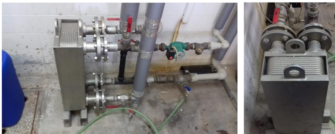
Obrázek 64. Deskový výměník pro ohřev vody na oplachy.
