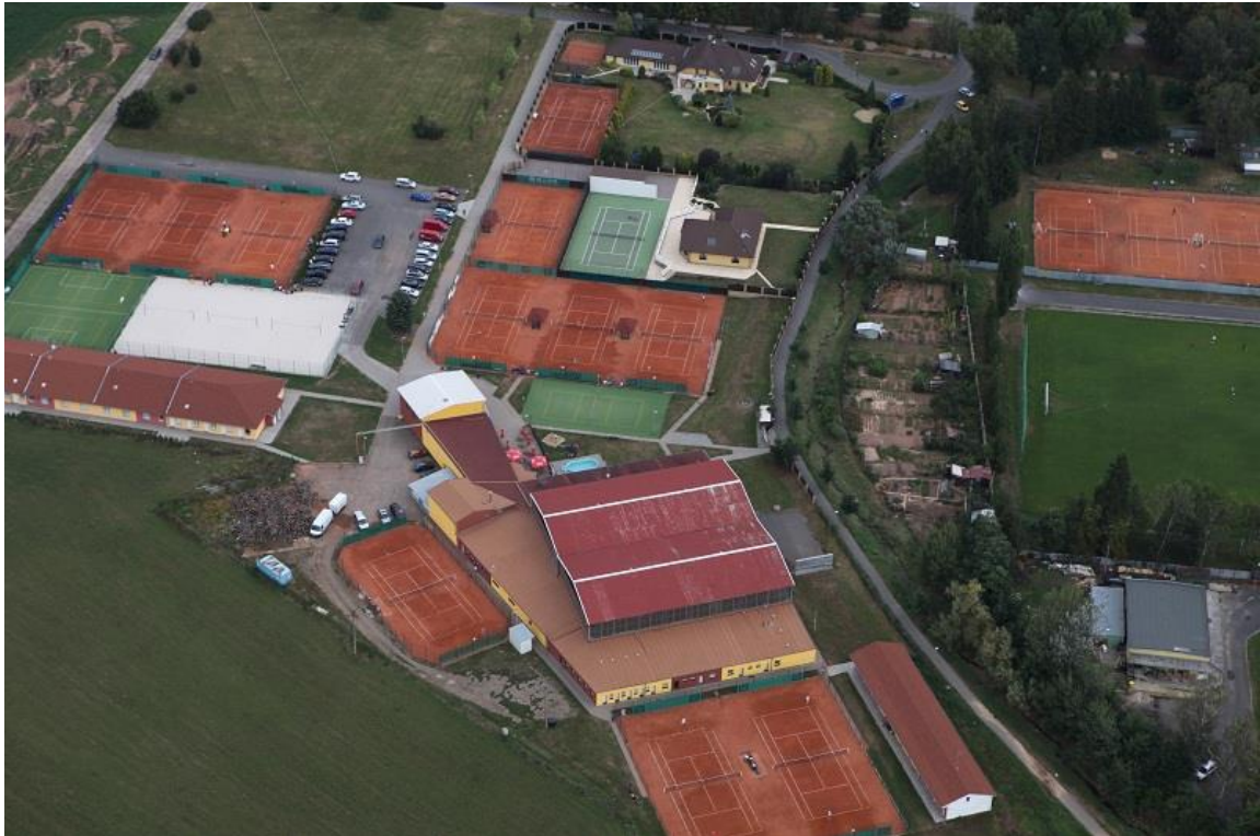
Obrázek 5 Pohled shora na objekt centra Cafex [43]
