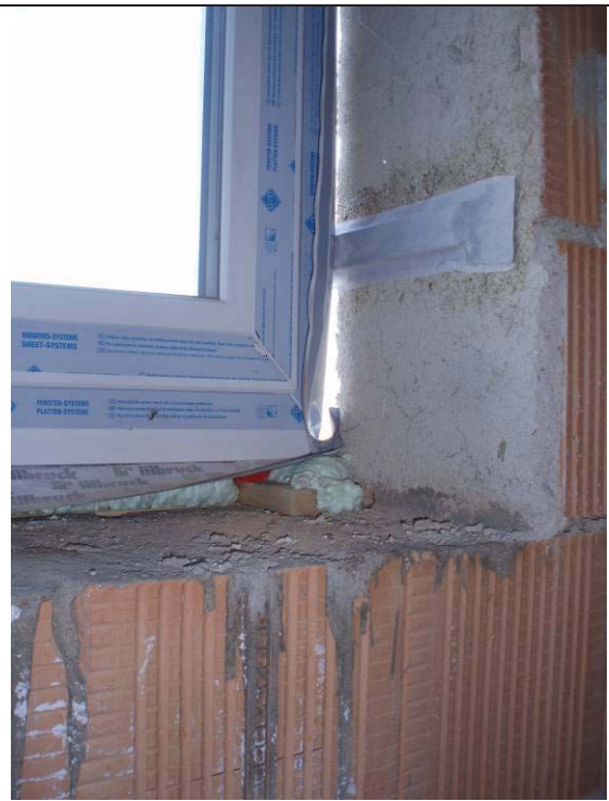
Obr. 22 Správné provedení těsnících pásek u kotvy
