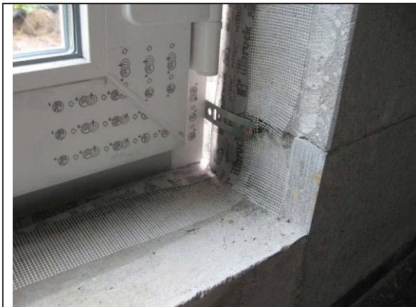
Obr. 16 Nevhodná volba a chybná montáž kotvicního systému
