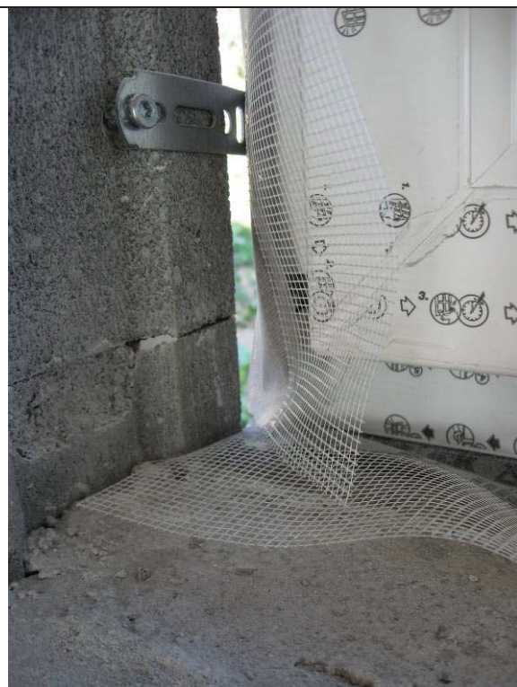
Obr. 19 Vnitřní ukotvení v ostění
