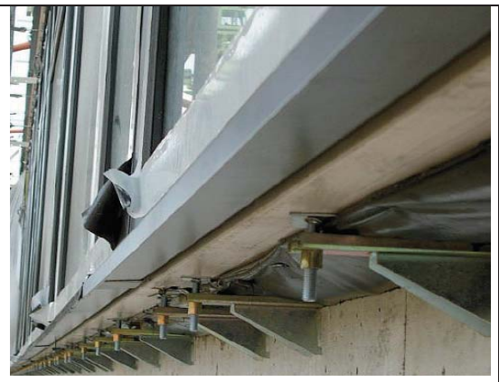
Obr. 23 a 24 Kotvení do vápenopískových cihel, betonu a pórobetnu
