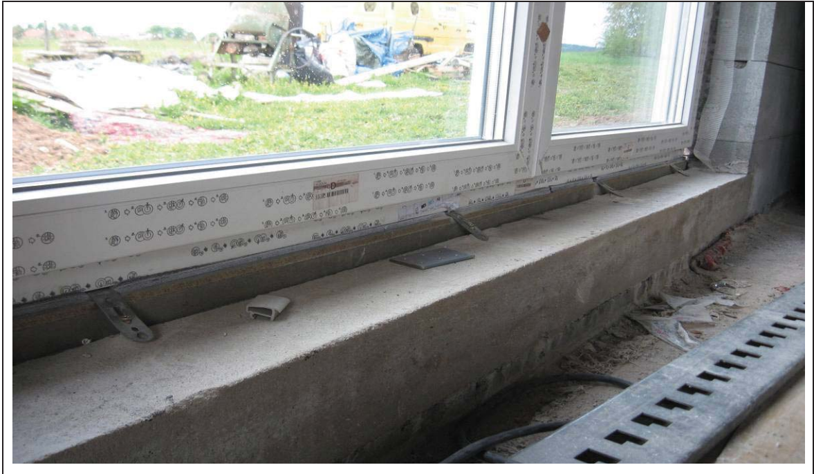
Obr. 20 Ukotvení okna u parapetu
