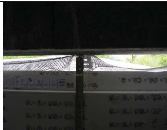
Obr. 17 Průhyb kotvy u nadpraží
