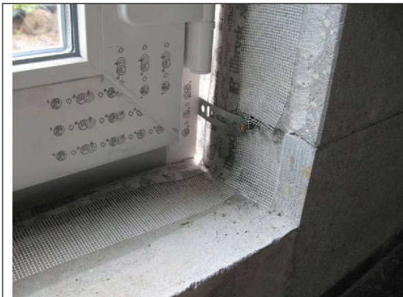
Obr. 16 Nevhodná volba a chybná montáž kotevního systému
