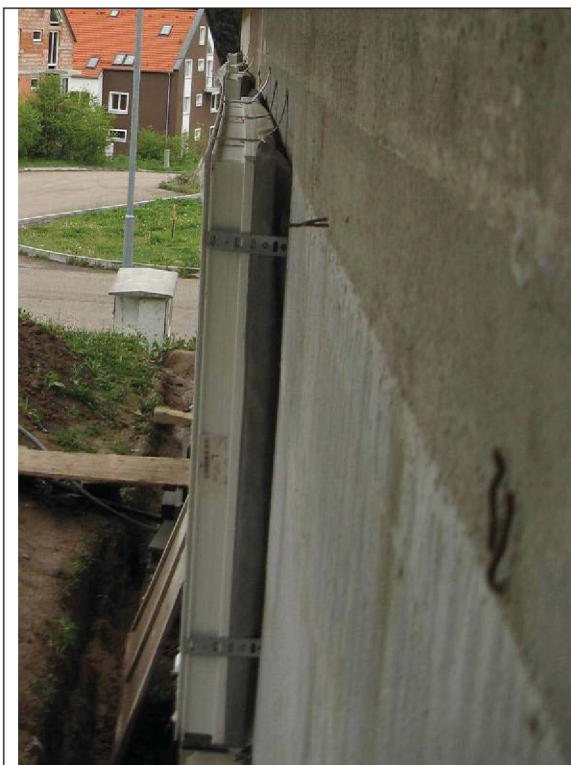
Obr. 18 Pohled na chybné ukotvení (exteriér)
