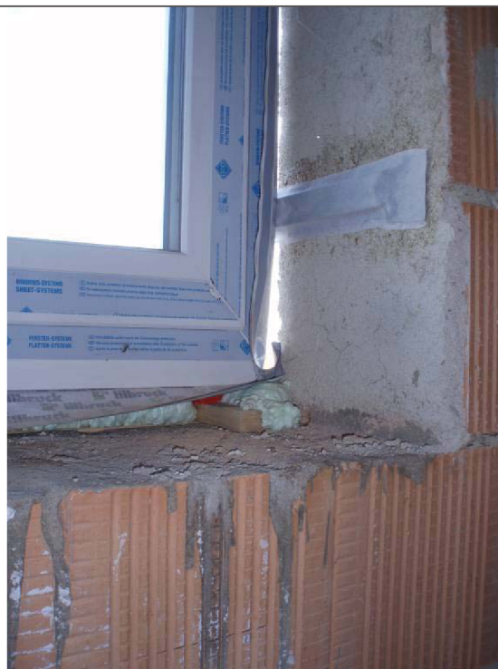
Obr. 22 Správné provedení těsnících pásek u kotvy
