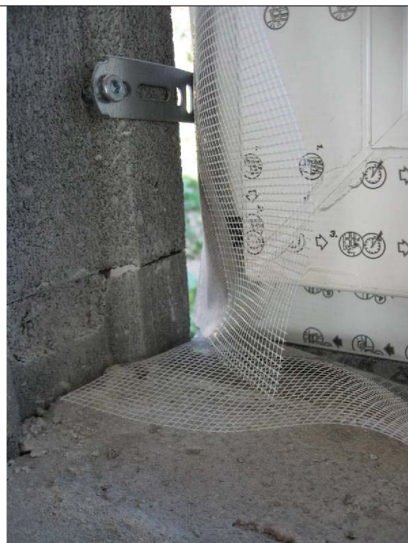
Obr. 19 Vnitřní ukotvení v ostění
