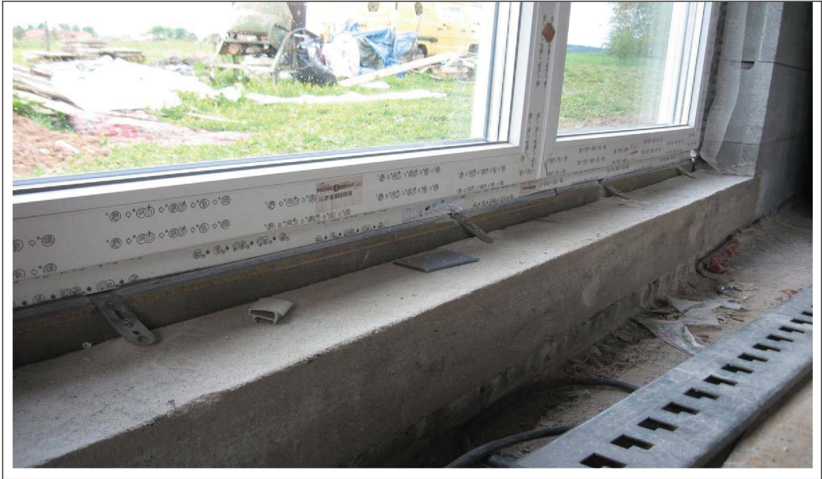
Obr. 20 Ukotvení okna u parapetu
