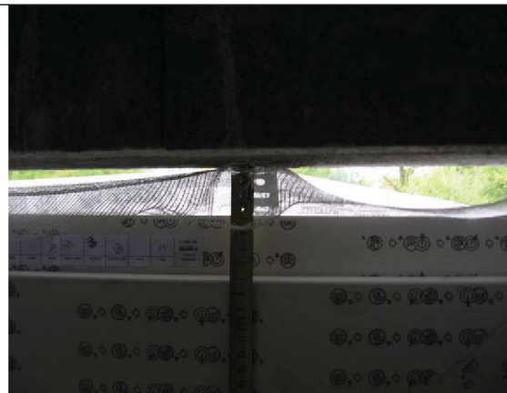
Obr. 17 Průhyb kotvy u nadpraží
