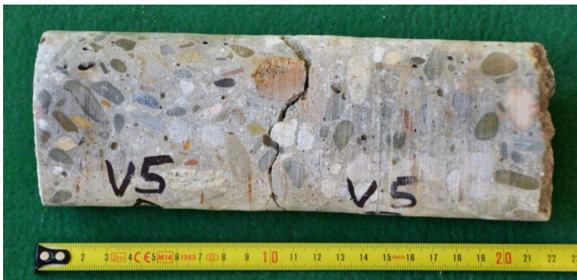
Obrázek 2 Označení a dokumentace jádrového vývrtu [15]
