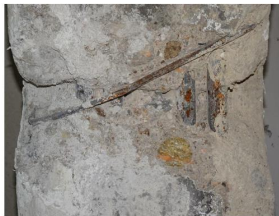
Obrázek 41 Vlevo schematický výkres zjištěné výztuže v místě sondy A8 – průvlak (v polovině rozpětí), vpravo sonda A8 – průvlak
