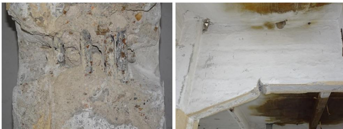
Obrázek 40 Sonda A7 – průvlak
