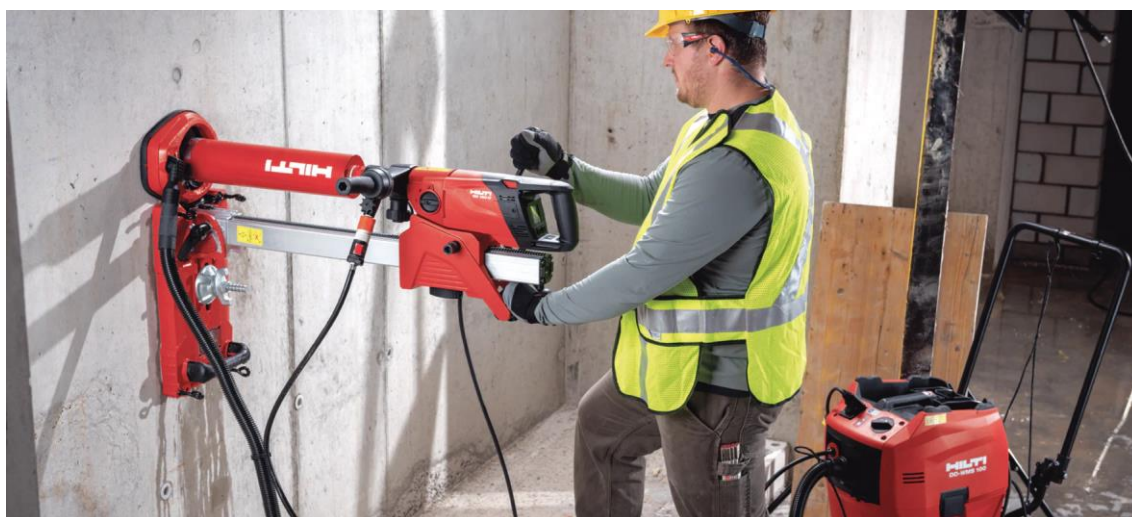
Obrázek 1 Provádění jádrového vývrtu pomocí vrtné soustavy [12]
