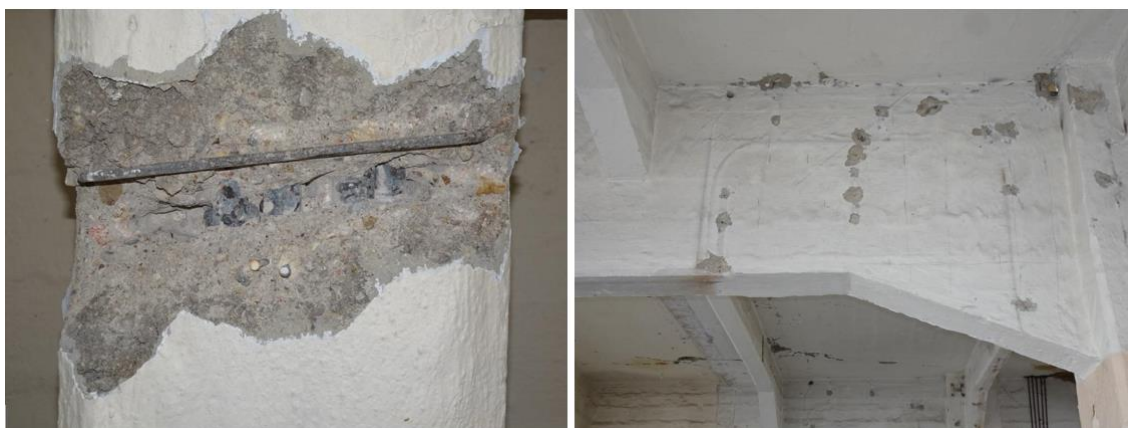
Obrázek 37 Sonda A6 – průvlak
