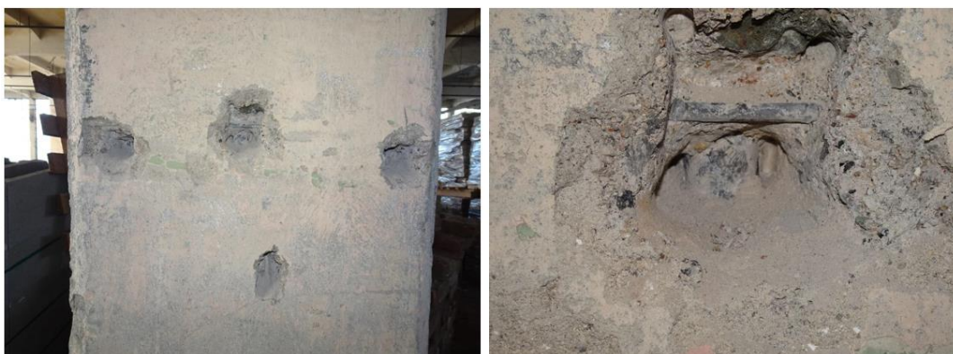
Obrázek 28 Sonda A2 – sloup
