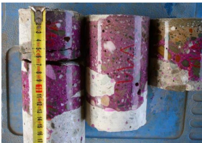
Obrázek 4 Zjištění míry karbonatace na odebraných vývrtech [18]
