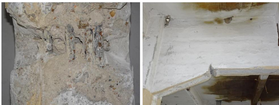
Obrázek 40 Sonda A7 – průvlak
