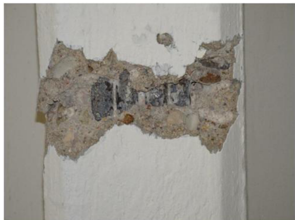
Obrázek 45 Vlevo schematický výkres zjištěné výztuže v místě sondy A10 – trám (v polovině rozpětí), vpravo sonda A10 – trám
