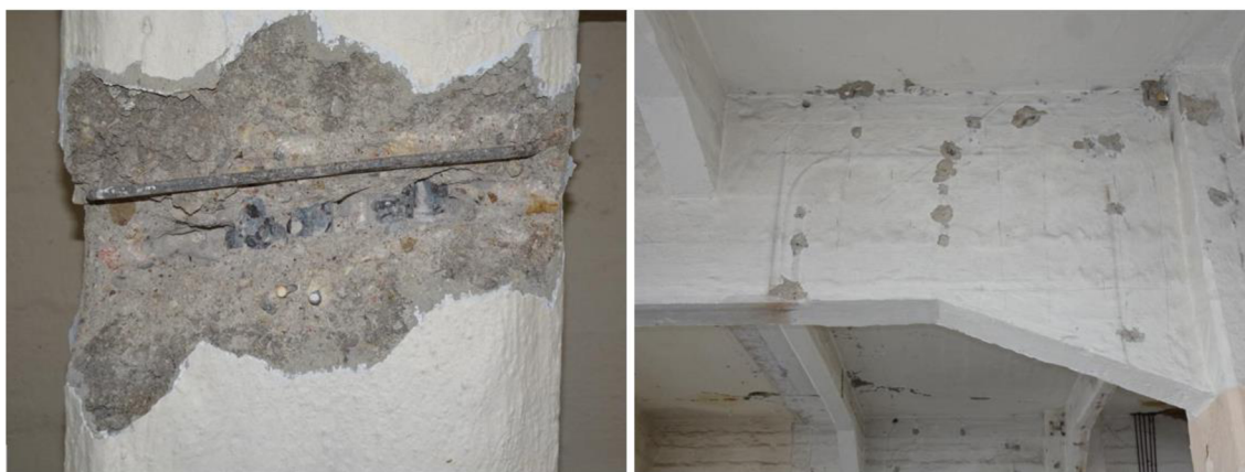
Obrázek 37 Sonda A6 – průvlak
