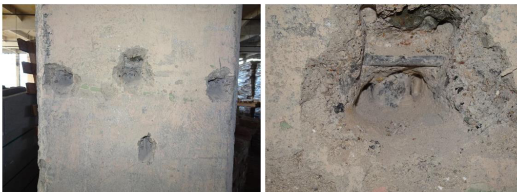
Obrázek 28 Sonda A2 – sloup
