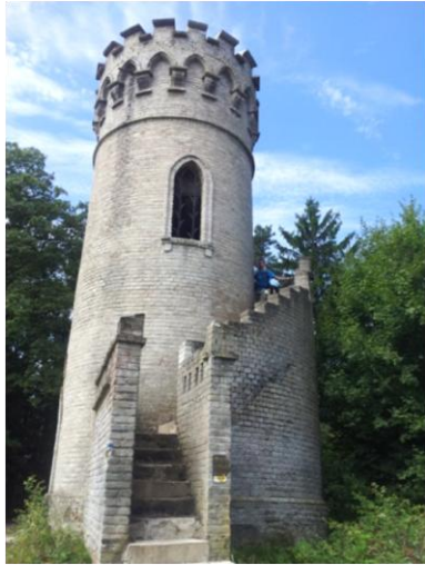
Obrázek č. 14 - Rozhledna Děd s točitým kamenným schodištěm
