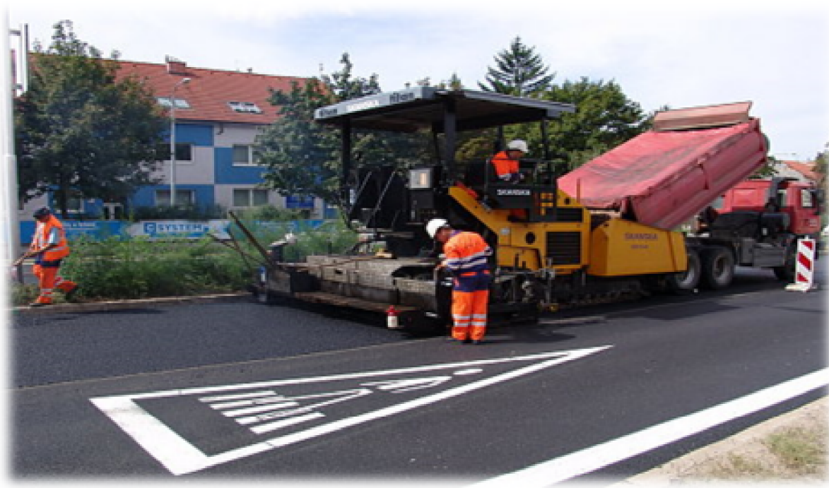
Obr. 4: Pokládka CRmB vrstvy [23]
