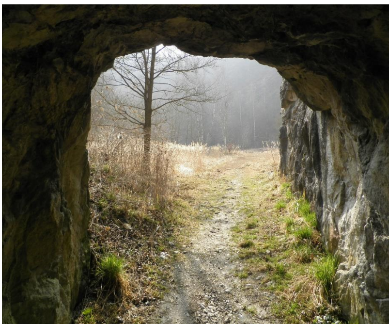
NPP Zlatý kůň (vlastní foto).
